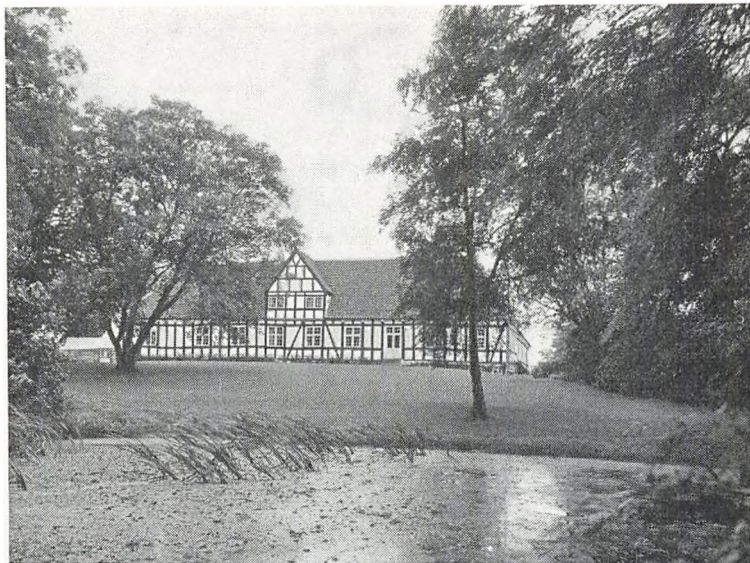
Hovedbygningen set fra haven (fot. Niels Elswing).
