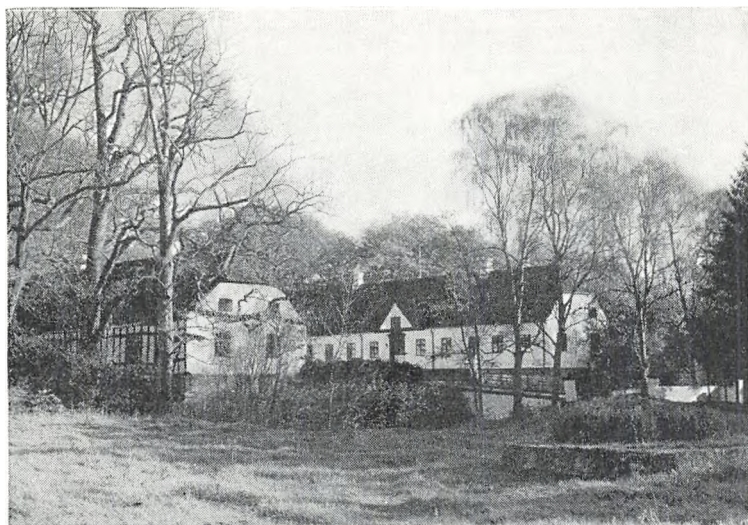
Hovedbygningen set fra nordvest (fot. Niels Elswing).
