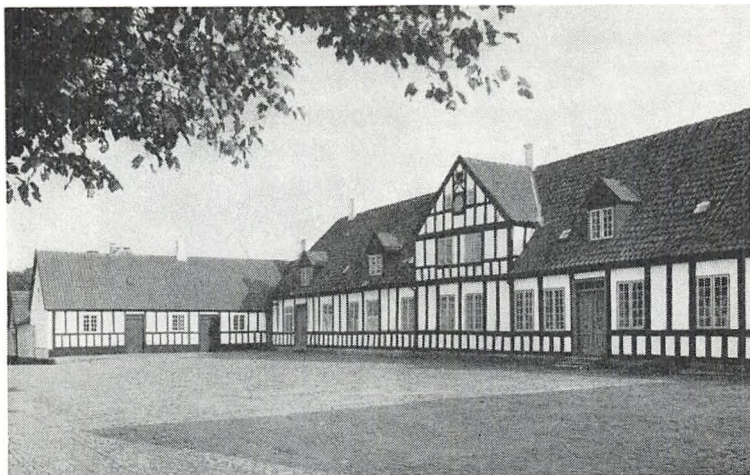
Hovedbygningen set fra nordvest (fot. Niels Elswing).
