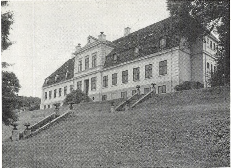
Hovedbygningen set fra haven (fot. Niels Elswing).
