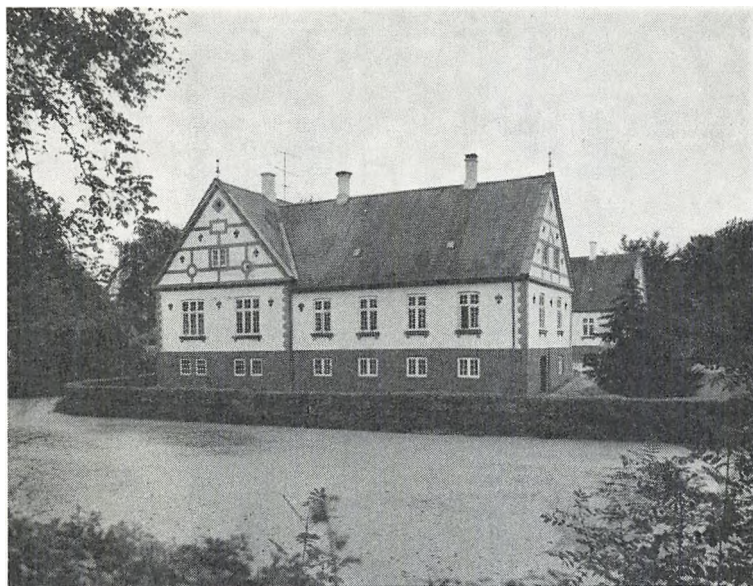
Hovedbygningen set fra nordvest (fot. Niels Elswing).
