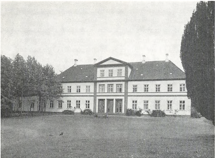
Hovedbygningen set fra haven (fot. Niels Elswing).
