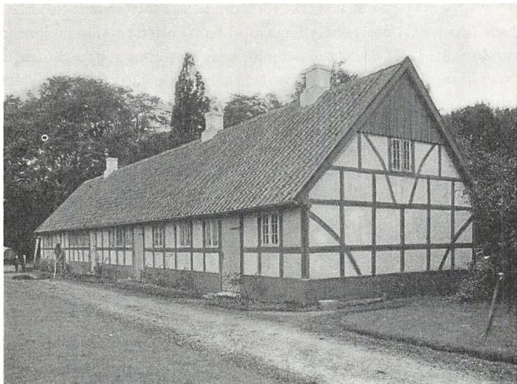
Bindingsværkslænge i avlsgården (fot. Niels Elswing).
