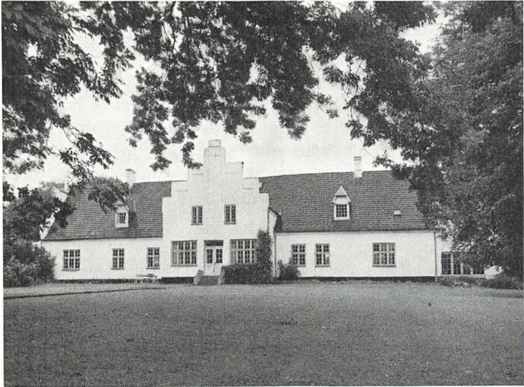
Hovedbygningen set fra haven (fot. Niels Elswing).
