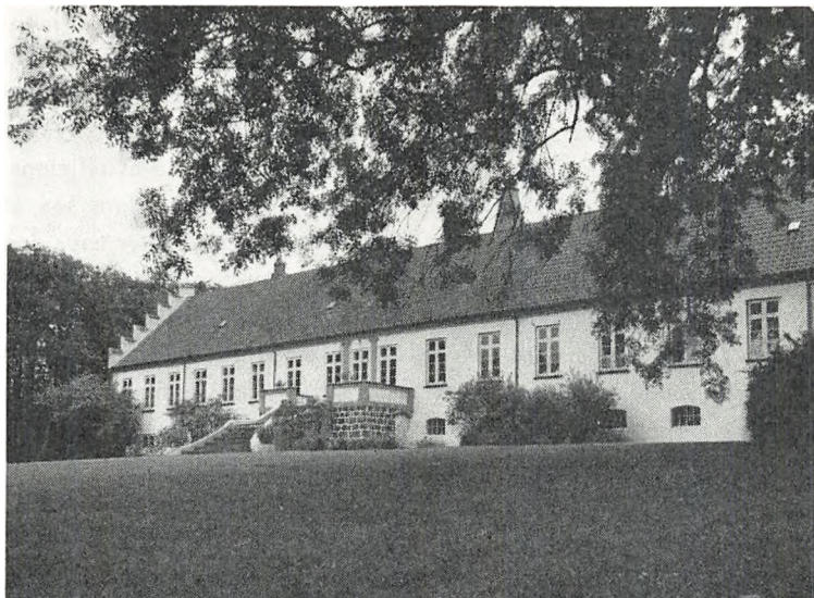
Hovedbygningen set fra haven (fot. Niels Elswing).
