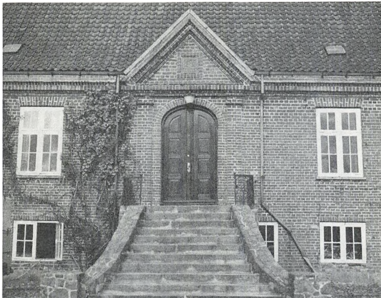
Hovedbygningens indgangsparti (fot. Niels Elswing).
