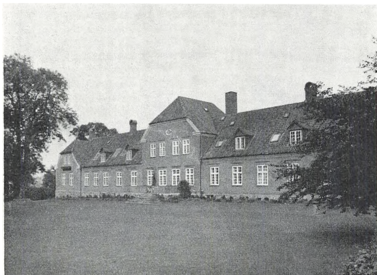
Hovedbygningen set fra haven (fot. Niels Elswing).
