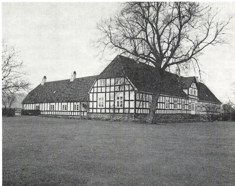
Hovedbygningen set fra haven (fot. Niels Elswing).
