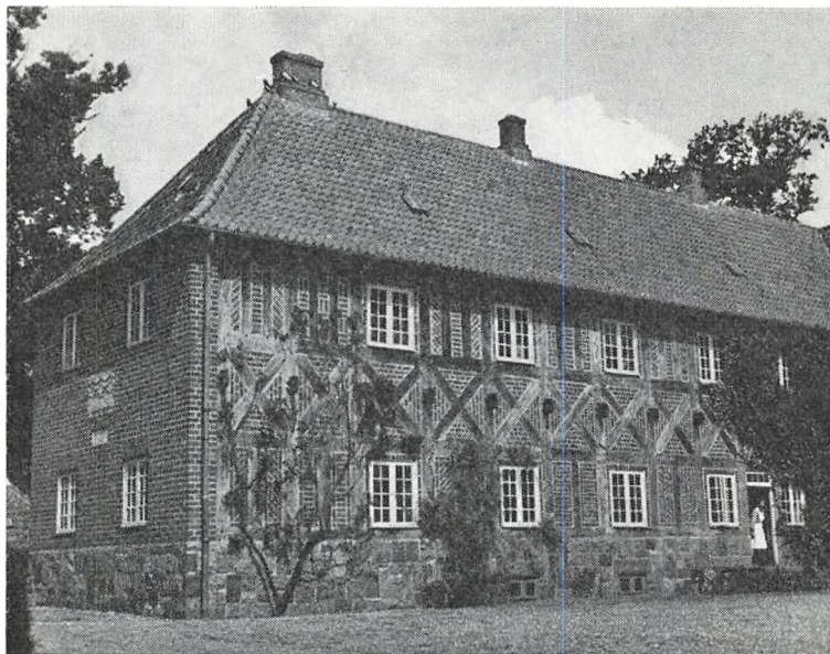
Hovedbygningens nordfløj med gammelt bindingsværk, genanvendt fra nordfløjen fra midten af 1500'erne (fot. Bror Bernild).
