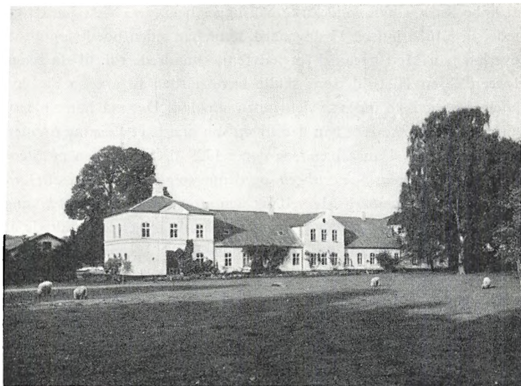
Hovedbygningen set fra haven (fot. Niels Elswing).
