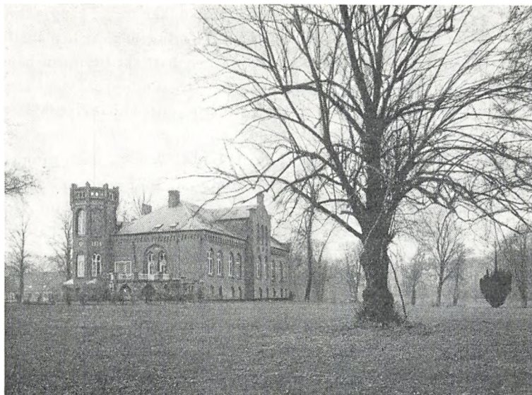
Hovedbygningen set fra haven (fot. Niels Elswing).
