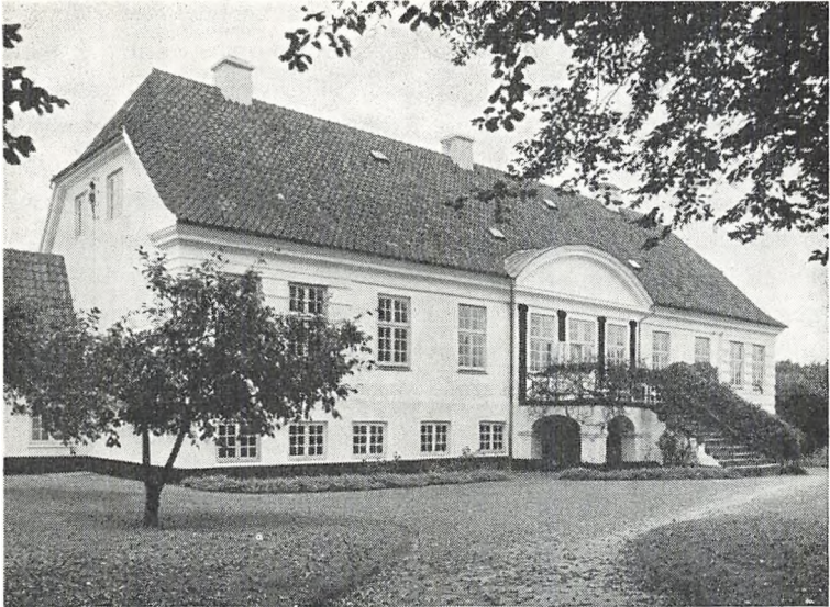
Hovedbygningen set fra haven (fot. Niels Elswing).
