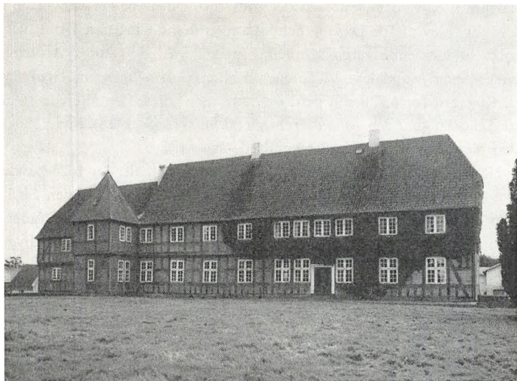
Hovedbygningen set fra haven (fot. Niels Elswing).
