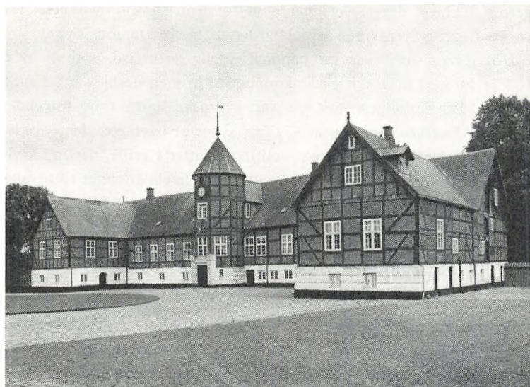
Hovedbygningen set fra nordvest (fot. Niels Elswing).
