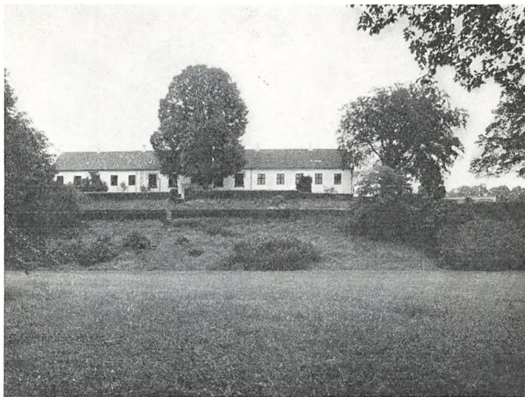
Hovedbygningen set fra haven (fot. Niels Elswing).
