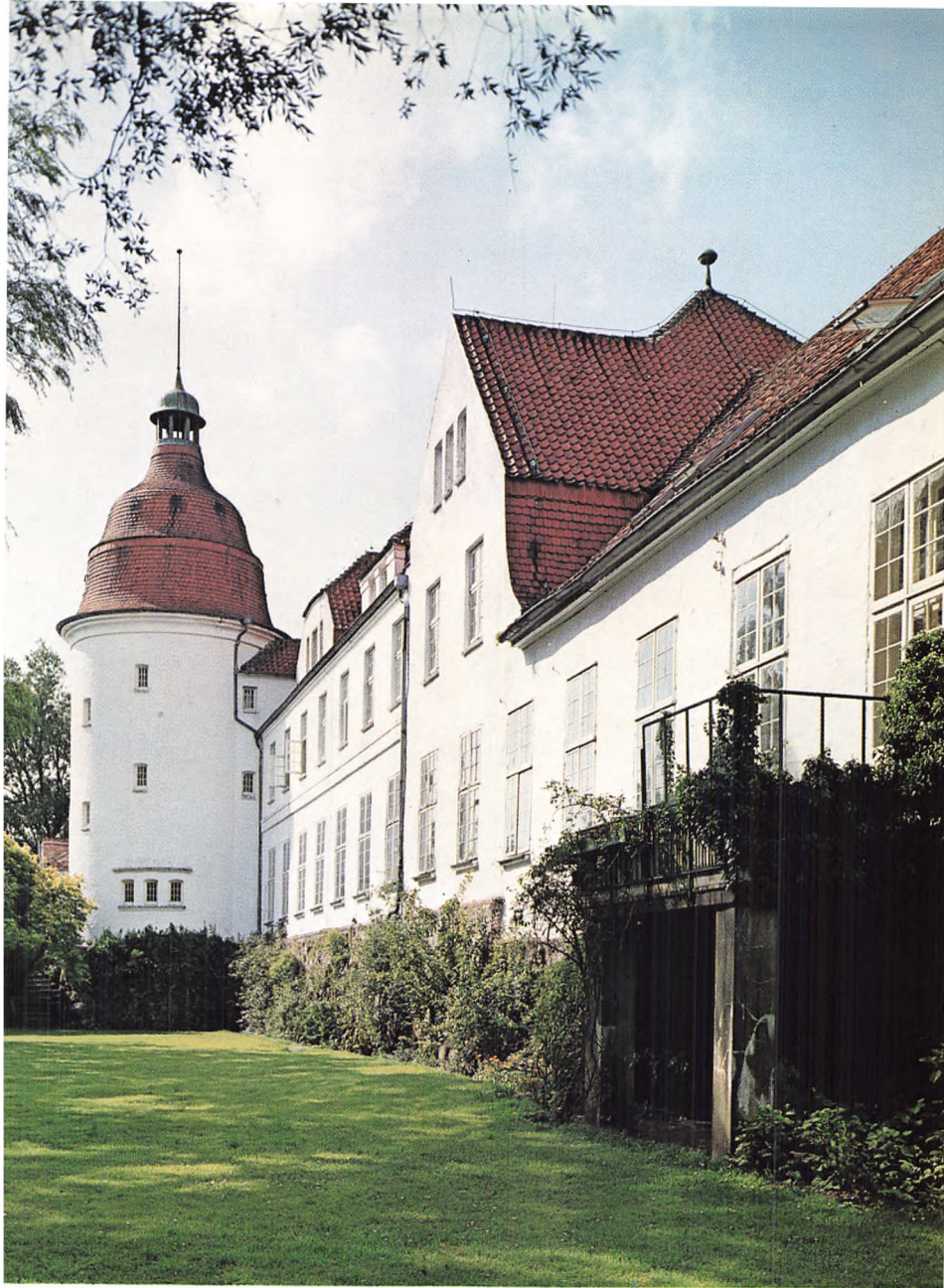
Nordborg Slots sydfacade (fot. Niels Elswing).
