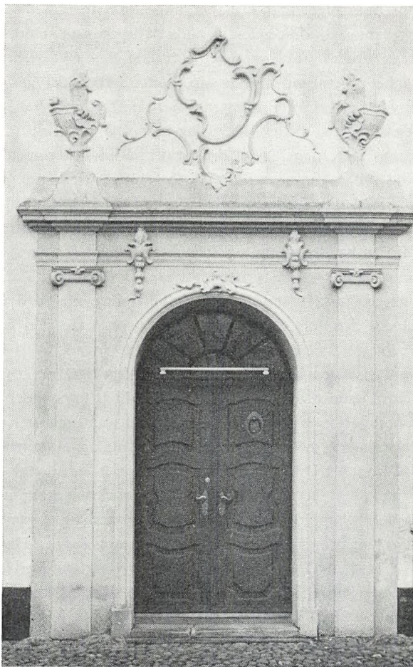
Portal med rokostuk på nordre sidefløj (foto. Niels Elswing).
