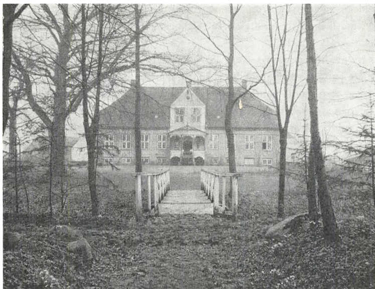
Hovedbygningen set fra haven (fot. J. & F. Lydom).
