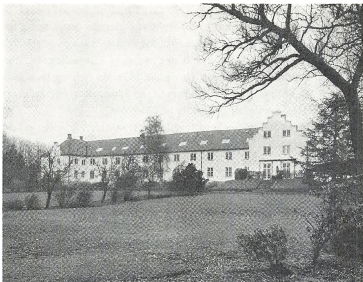
Administrationsbygningen set fra syd (fot. Niels Elswing).
