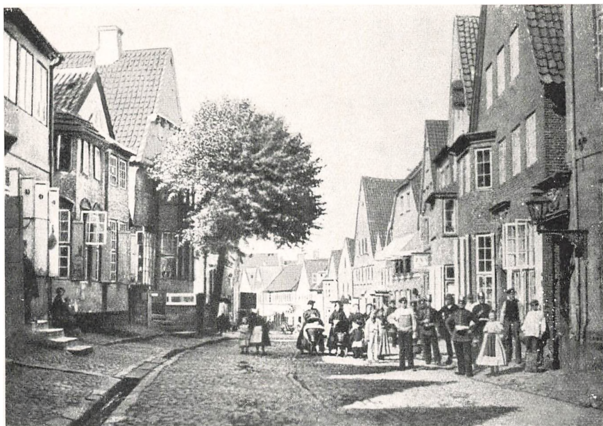
Abb. 22 Norderstraße in Flensburg, Haus Nic. H. Lorch rechts mit offener Bodenluke
