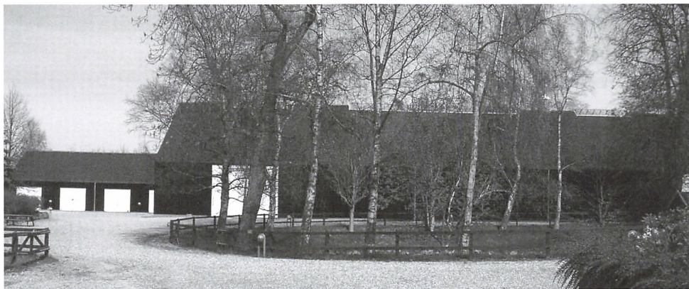
De sorte bygninger er opført som lagerhaller for den daværende ejer, Carli Gry A/S.
