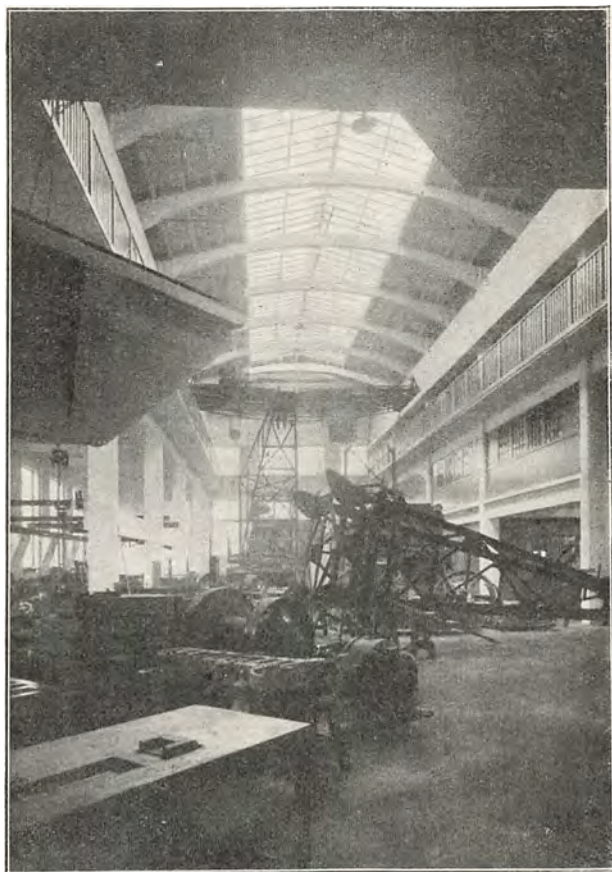
Monteringshal for Fabrikation af Kraner o. l. (Titan, København).
