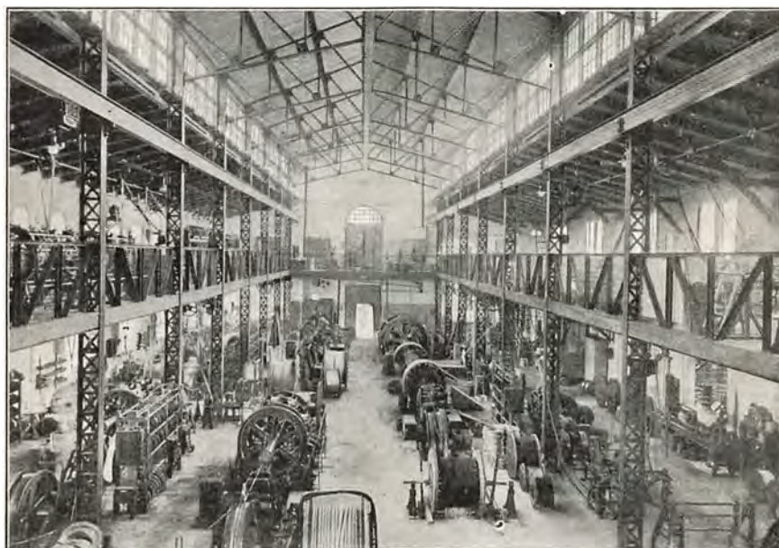
Fra Maskinhallen i en Kabelfabrik. (Nordiske Kabel- og Traadfabrikker, København).
