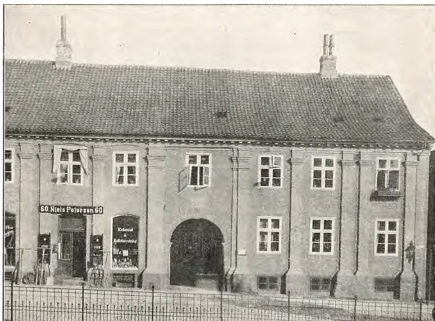
Odense: Overgade 60. (H. M. fot.)
