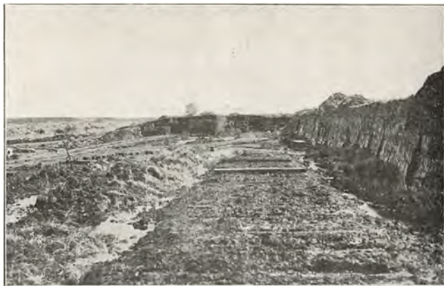
Afgravning af Tørvemassen i en Højpose. (R. H. Stamm fot.)
