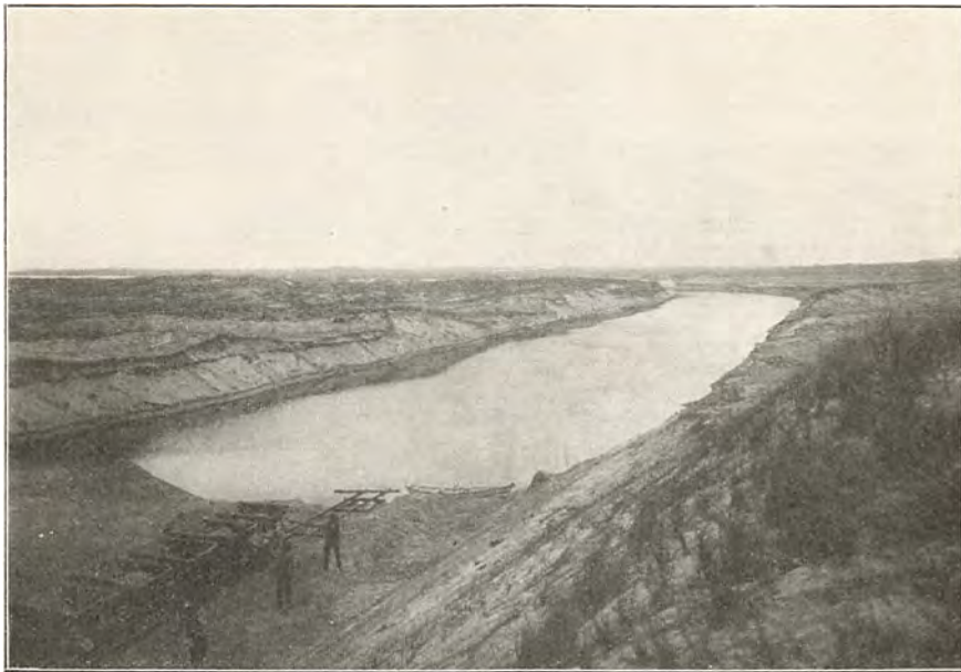
Ringkøbing Fjords nye Udløb ved Gødelen. Udgravning af Kanalens yderste Del, nærmest Havet. (Axel Jessen fot. 6. Aug. 1915)
