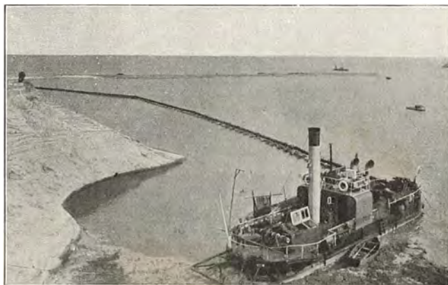
Sandpumper i Virksomhed ved Hvide-Sande Kanalen. (M. Lundbo fot.)
