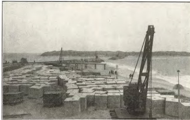
Bygning af Dæmninger ved Hvide Sande.
