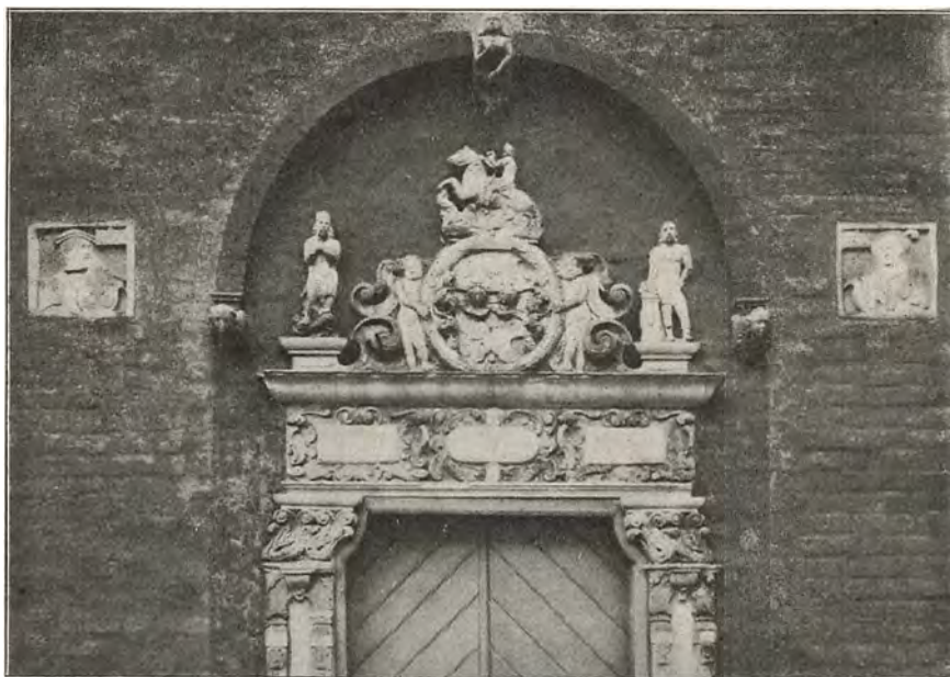
Portal paa Villestrup. Til Siderne ses Stenrelieffer af Axel Juul og hans Hustru, hvilke byggede Gaarden 1542. (K. Hude fot.)
