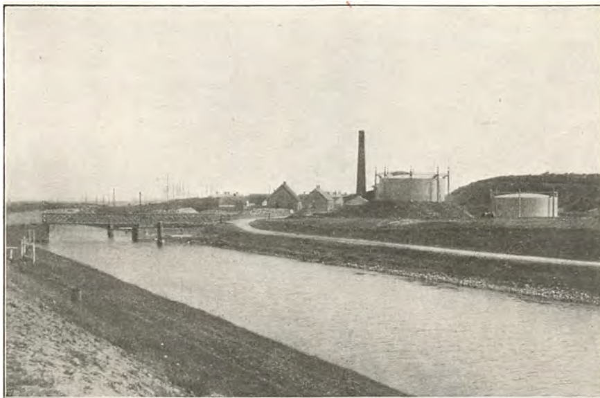
Frederik VII's Kanal ved Løgstør. (Stenders Forlag)
