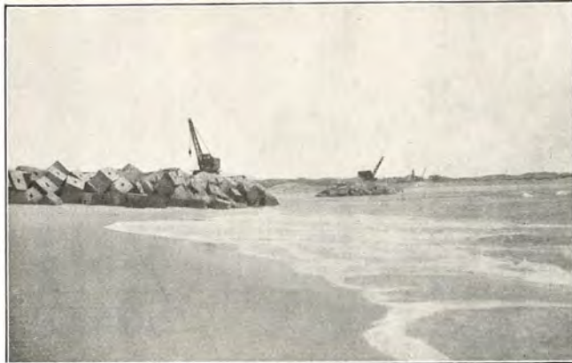
Dæmninger ved Hvide Sande Kanalen.
