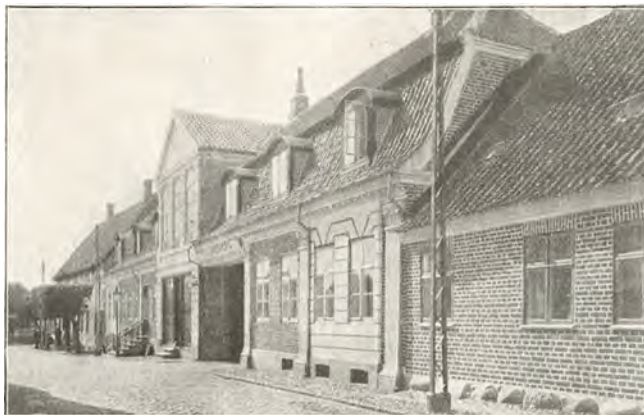
Ringkøbing. Torvets Vestside. (H. M. fot.)
