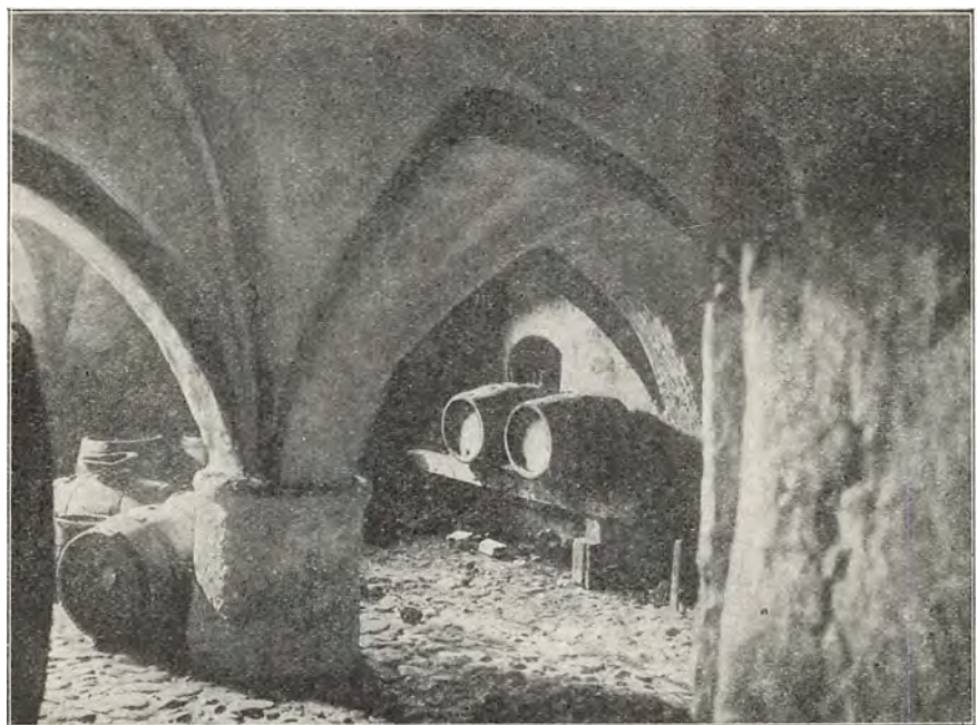
Bogense. Brænderigaardens Kælder. (H. M. fot.)
