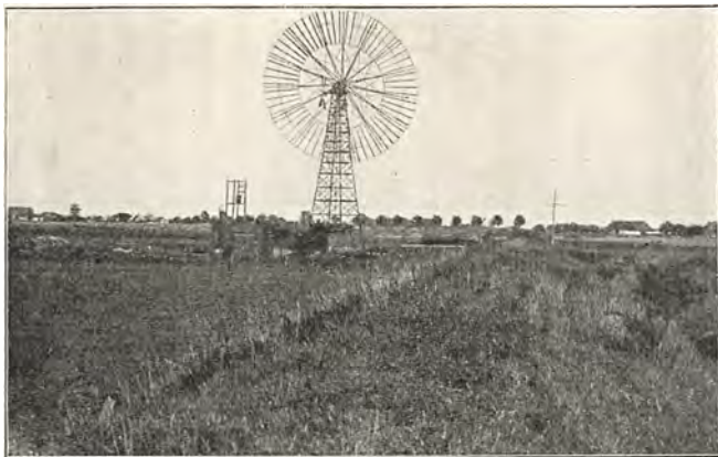
Dige og Pumpeværk ved den tørlagte Rødby Fjord. I Baggrunden t. v. Rødby. (M. Lundbo fot.)
