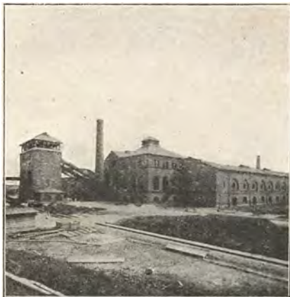
Valby Gasværk. (Fot.)
