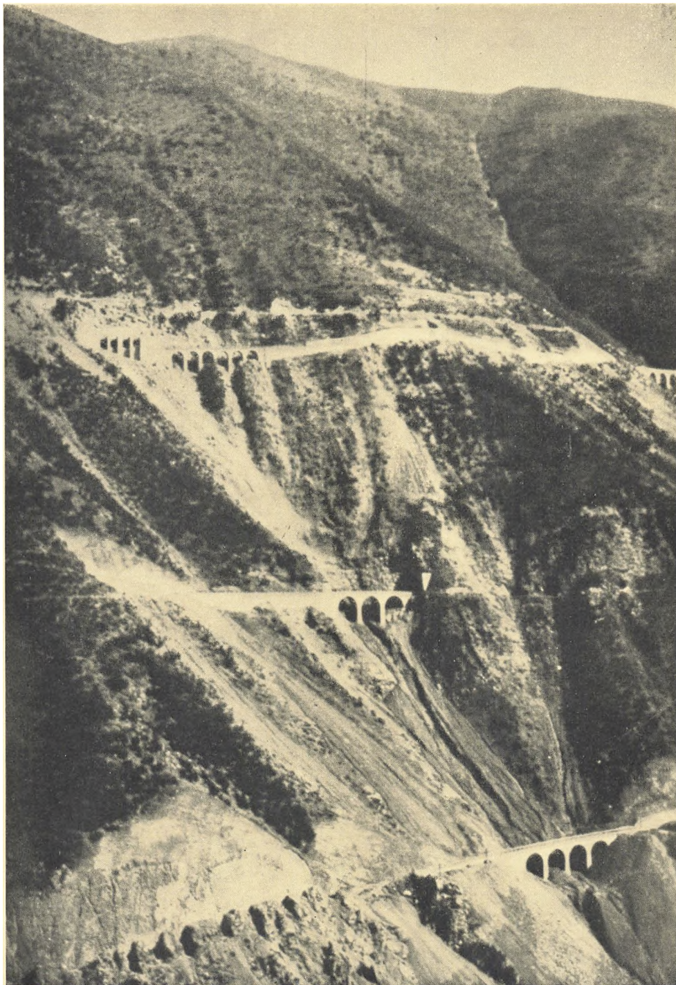
Fra Anlægget af den transiranske Jernbane. Linieføring i 3 Etager paa Nordlinien
