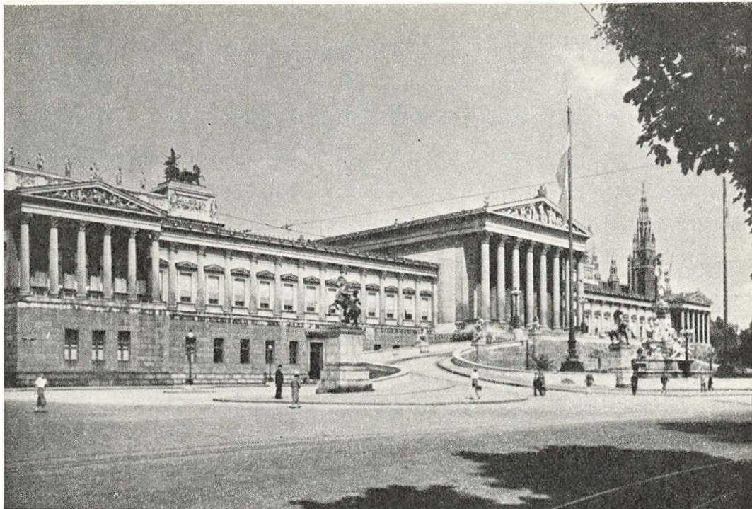
Rigsdagsbygningen i Wien, bygget af Theophilus Hansen
