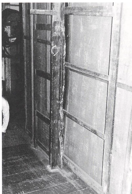
Kulisserammer på Rønne Theater. Man ser det stigeagtige stel, hvorpå kulisserne blev hængt. Se foregående illustration samt teksten side 142. – Forf. fot. 1962.
