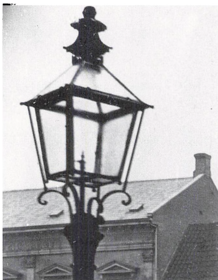
Dette tidlige fotografi viser en gaslygte fra Odense og dermed en af de allerførste, der blev opstillet i Danmark. I silhouet tegner kameraet alle lygtekurvens linjer. Det ses, at den er åben i bunden, hvor gasrøret og brænderen stikker op. Odense Bys Museer.
