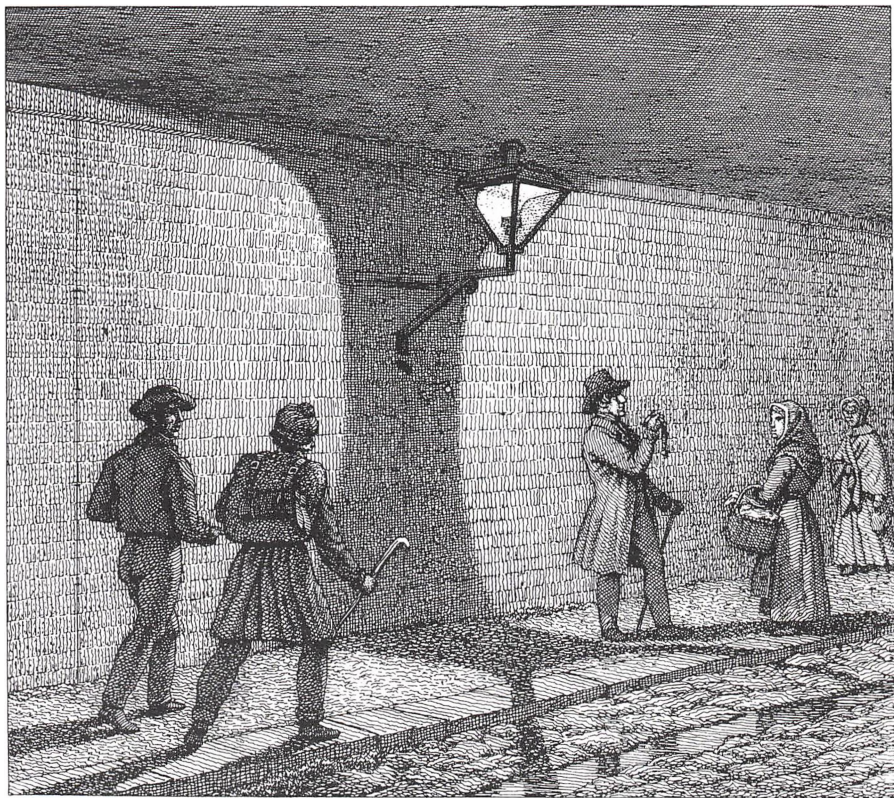
Nattebilleder, der viser gadelygter i funktion, er yderst sjældne. Men C. W. Eckersbergs radering af den lysende lygte på en mur hører til undtagelserne. Grænsen mellem lys og skygge på muren viser, at lygten er forsynet med en »reverbator« – et hulspejl, der reflekterer lyset og kaster det udefter. Den kongelige Kobberstiksamlng.
