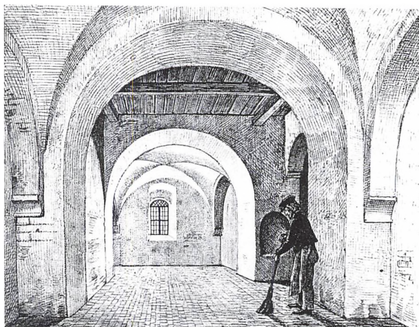
Tårnrummet i Broager kirke. Bag ved den fejende mand ses én af tårnets to rundbuede vievandsnicher. Tegning: J. Kornerup 1862.
