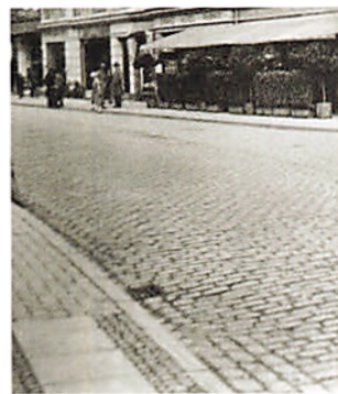
Fortov med forskellige typer af belægning i Jernbanegade i Nykøbing Falster 1928. Foto Det kgl. Bibliotek.
