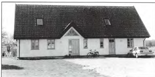
Efter en brand for nogle år siden, er ejendommen genopført i ny skikkelse. Foto fra april 2004. (Foto: Peter Kalko).
