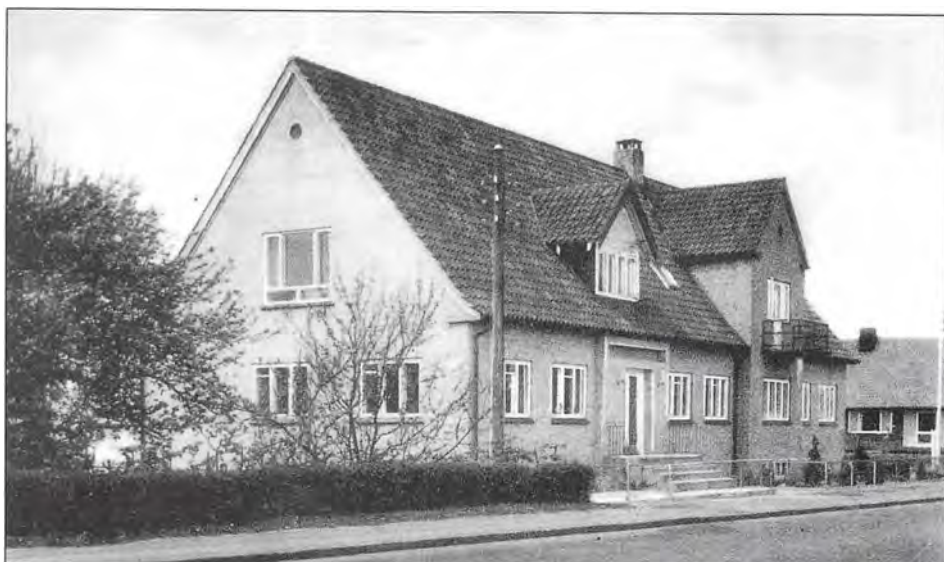
Helsing-Valby kommunekontor på Frederiksborgvej. Er i dag revet ned.
