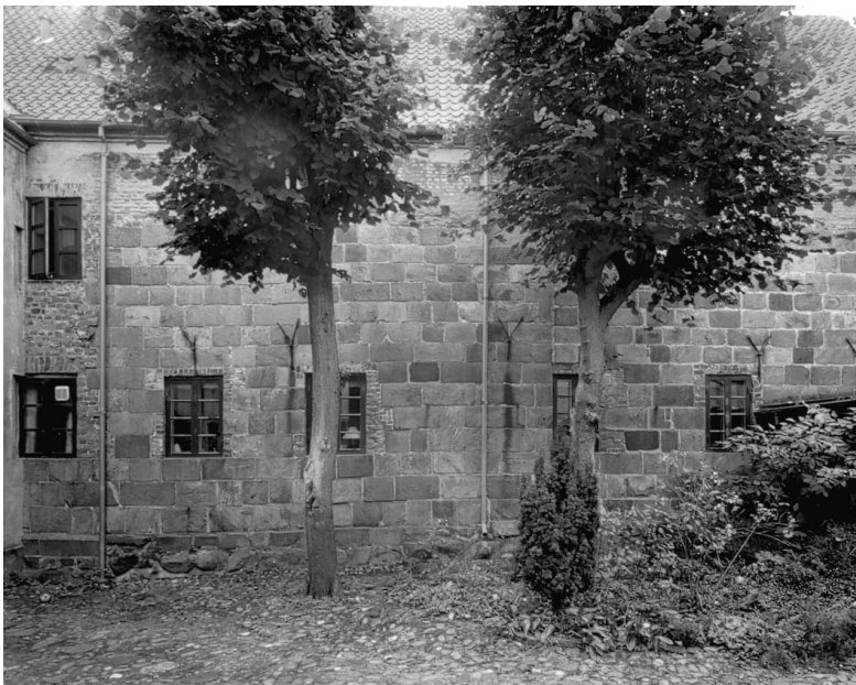
Gårdsiden af den såkaldte Karnapgården i Skt. Mogensgade. Store dele af murværket er tydeligvis opført af granitkvadre fra en eller flere af Viborgs nedlagte kirker. Foto: Lars Guldager
