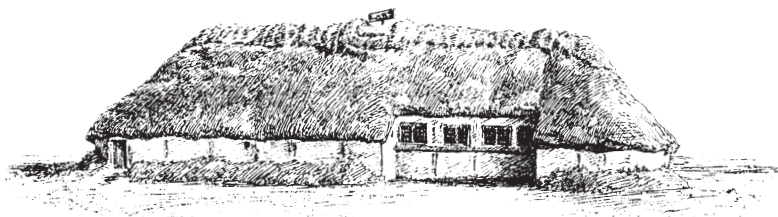
Stuehus på Mors, tegnet i 1880'erne. Væggene er lave, og stråtagets tagskæg er kun godt 1 m over jorden, bortset fra det lille stykke sydvendte husmur med nogle få små vinduer. Huset har åbent ildsted med røgaftræk gennem en lyre i taget. Tegning af Carl Jensen i R. Mejborg: Gamle danske hjem, 1888.
