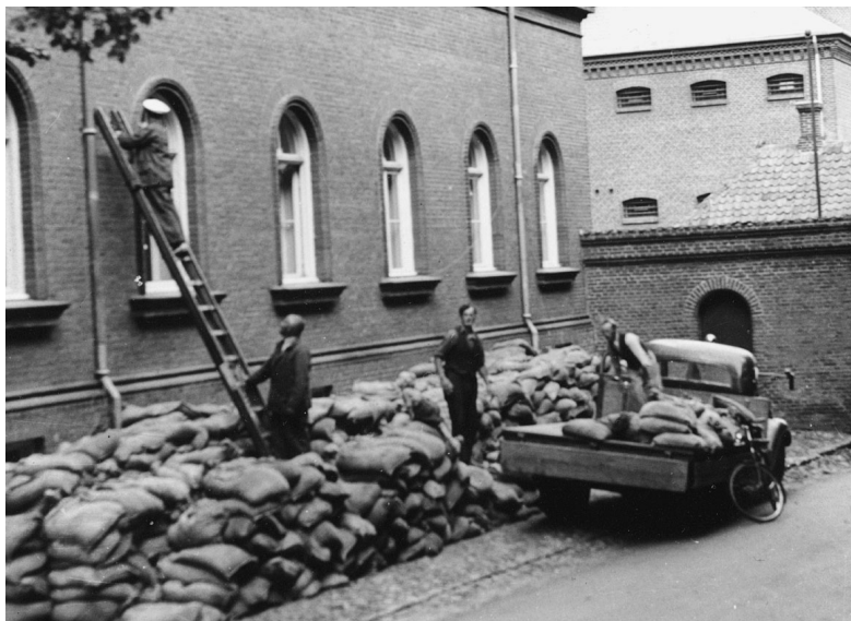
Rådhuset i Viborg fotograferet mellem 1940 og 1943. Der udføres sikringsarbejde ved bygningen, til imødegåelse af sabotage og bombardement. I baggrunden ses arrestbygningen, der få år senere skulle komme til at spille en central rolle i retsopgøret efter besættelsen. Det var i cellerne i den øverste etage, bag de to cellevinduer til højre, de dødsdømte tilbragte deres sidste døgn, hvilket for Viborgs borgere var kendeligt ved, at der brændte lys i cellerne døgnet rundt. Når der sad en enkelt dødsdømt i arresten, anvendtes cellen yderst til højre. Stod to dødsdømte for henrettelse, anvendtes tillige celle nummer to fra højre. Foto i forfatterens samling.
