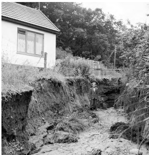
Bortskyllet hulvej ved »Æ krat«. Foto i Lokalhistorisk Arkiv for Viborg Kommune.
