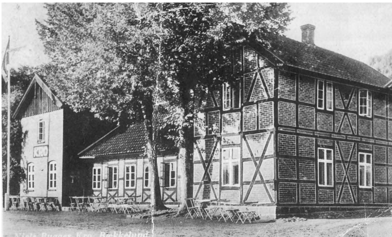
Niels Bugges Kro før 1948 visende dels sydflojen, bygget i 1890, dels nordflojen af bindingsværk, der blevet revet ud i søen. Yderst i billedets højre kant ses tagkanten af det tidligere møllehus, der nogenlunde intakt blev stående. Postkort 1948 i privateje.
