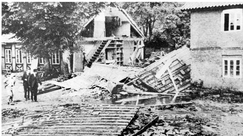
Niels Bugges Kro's nordøstfløj, som arkitekten Martin Nyrop (1840-1921) havde bygget i bindingsværk for onkel Krabbe på Hald i 1871. Fløjen blev sammen med det meste af savværket flået over og havnede ude i Hald Sø, revet med af vandstrømmen oppe fra Troldeslugten. Midterste bindingsværksdel, som ses på billedet, står endnu. Yderst til højre ses det tidligere møllehus. Staten overtog netop dette år Hald, men besluttede at genopføre en fløj på kroen som erstatning for Nyrops bygning. Billed Bladet 27. juli 1948, s. 3.
