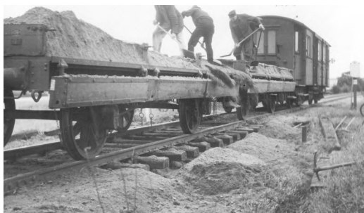
Der fyldes ballast under svellerne ved Stanghede. Foto i Lokalhistorisk Arkiv for Viborg Kommune.
