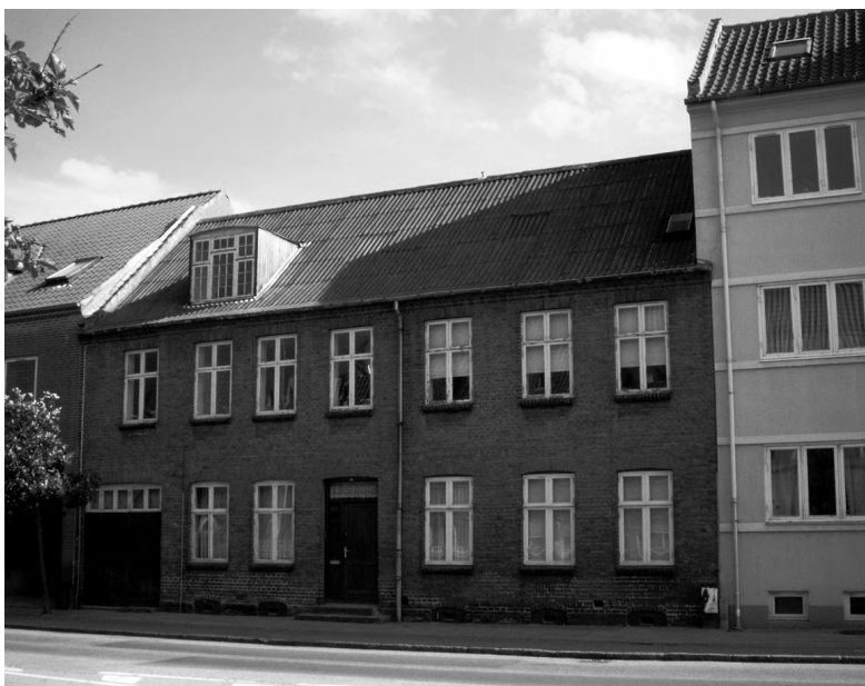
Skottenborg 9a i Viborg, da det i 2005 var blevet solgt til nedrivning. Huset rummede seks lejligheder, og bag det tildækkede vindue til venstre fandtes der til 1965 en cigarforretning. Foto Kristian Buhl Thomsen 2005.
