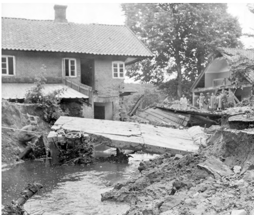
Niels Bugges Kro efter dæmningsbruddet, set fra mølledammen. Til venstre det beskadigede møllehus. I baggrunden krostuens åbne gavl. Foto i Lokalhistorisk Arkiv for Viborg Kommune.
