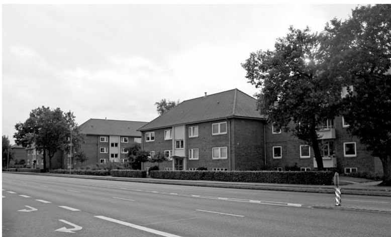
Ringparken på Ringvejen, opført i 1955 af Boligselskabet Viborg. Til venstre ses en af de vest-øst-vendte blokke, derefter en af de nord-sydvendte blokke med facade mod Ringvejen, fulgt af en lille mellembbygning og en blok som den til venstre. Foto Ole Degn 2009.
