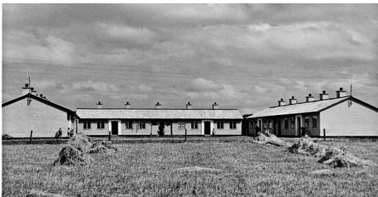
Husvildebarakkerne på Nørremarksvej 3. De blev bygget i 1942 og nedrevet i 1985, efter at de sidst havde været i Forsvarsbrødrenes besiddelse. Foto Zacho ca. 1945 i Viborg lokalhistoriske Arkiv.
