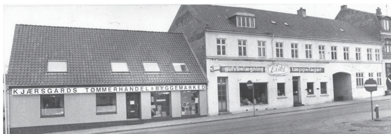
Tømmerhandelens butiksfacade i Gravene. Bygningerne blev nedrevet i 1987 for at give plads til Supermarkedet Føtex. Foto ca. 1980 i Viborg Lokalhistorisk Arkiv (4446).
