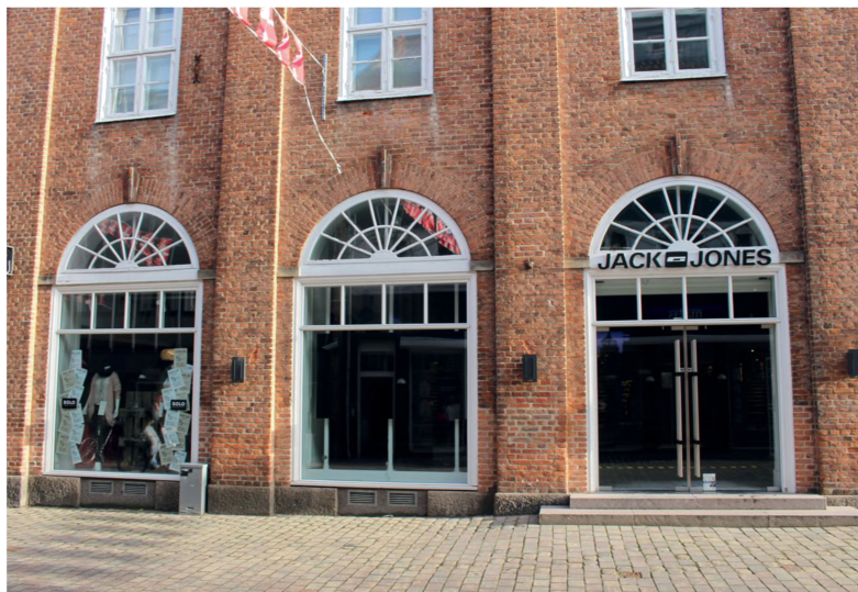
Viborg Posthus' facade mod Sankt Mathias Gade, fotograferet efter, at de store småsprossede vinduer i stueetagen er blevet skiftet ud med store forretningsvinduer og et dørparti, og portgennemkørselen i vestfaget er blevet inddraget i butikslokalerne og forsynet med en dør. Foto Ole Degn 2015.
