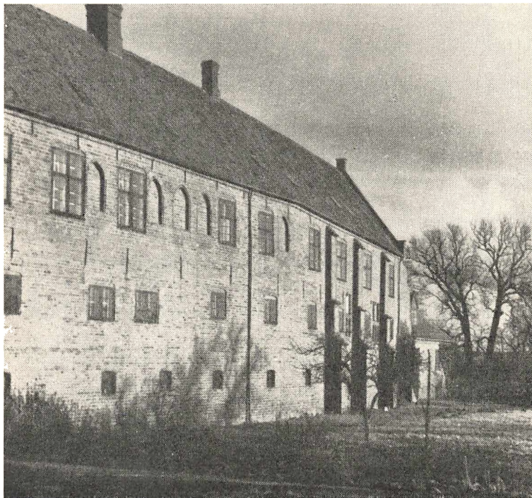
Fig. 9. Esrom klostrets bevarede middelalderlige sydføj, set fra sydvest. Forf. fot. januar 1953.
