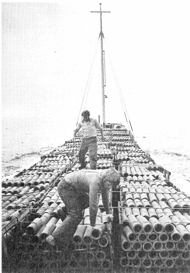
m/s »Kamina« af Asaa lastet med mursten og drænrør på vej fra Kolberg til Bergquara. Forf. fot.
