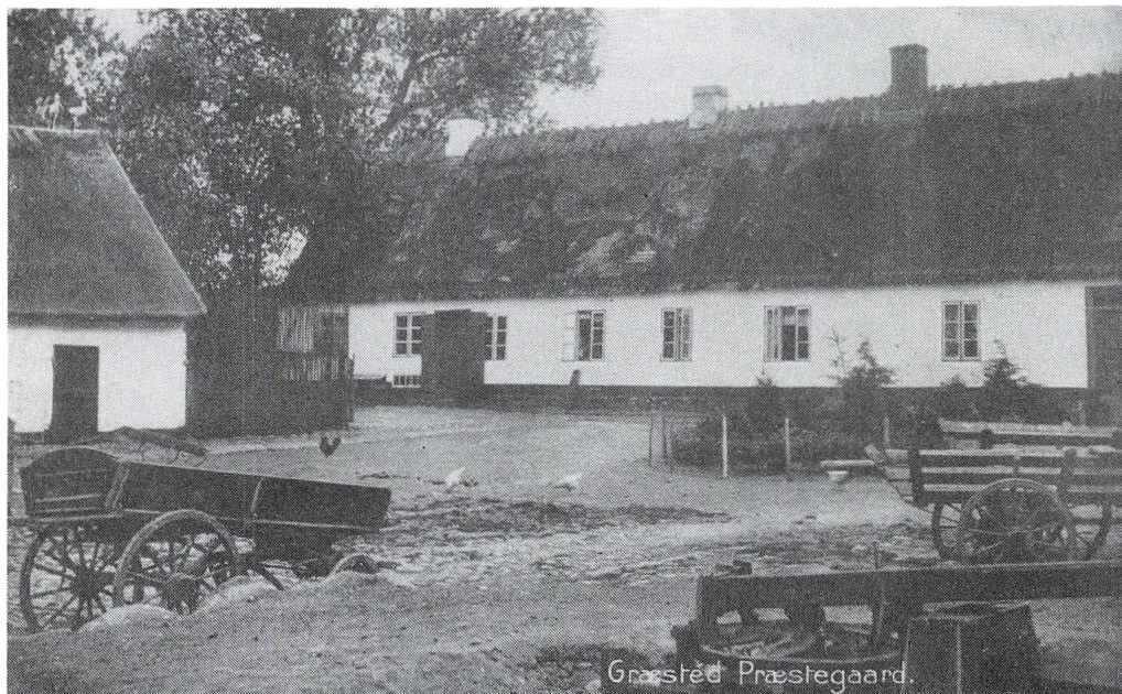
fig. 6: Græsted Præstegård. Disse bygninger blev opført efter branden i 1784, men nedrevet 1927.
