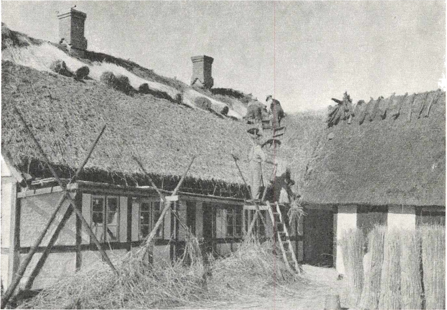
Tækning af et bindingsværkshus på Vestfyn. Tækkemændene arbejder dels fra et stillads, dels på små tækkestole, som kan stikkes fast i taget. B. Stoklund fot. 1956. Nationalmuseet.
