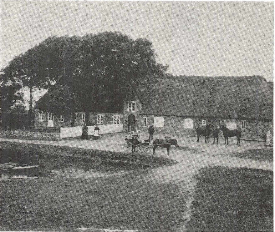
Gammel, grundmuret gård i Sdr. Sejerslev på Tønder-egnen. Den lange hovedlænge rummer både stuehus og stald. Bagved ligger laden, hvis stråtag skimtes til højre. Ældre fotografi i Nationalmuseet.
