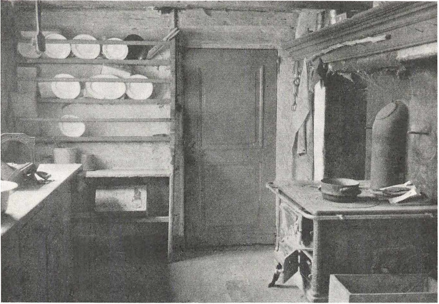
Køkken i en gård fra Horreby på Falster. Den brede, åbne skorsten med sin profilerede overligger er muret til og forsynet med komfur. På bagvæggen tallerkenræk fra gulv til loft og under vinduet et kistebord, der oprindeligt stod i dagligstuen. A. Steensberg fot. Dansk Folkemuseum.
