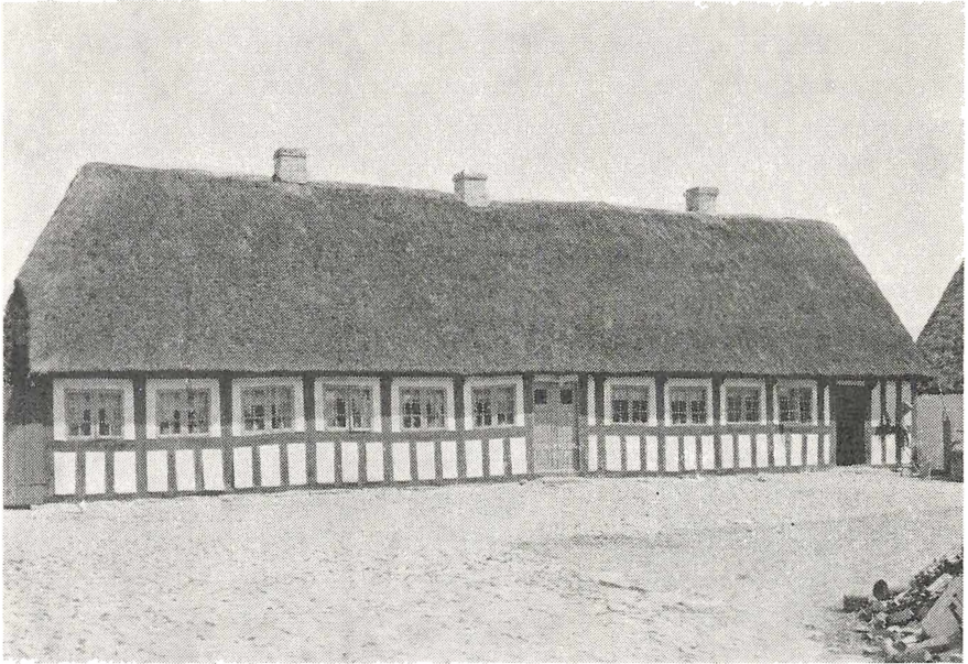
Stuehus til en gård i Erritsø ved Fredericia. Typisk østjysk bindingsværk med svære egestolper og meget fyldtømmer. H. Zangenberg fot. 1930. Nationalmuseet.
