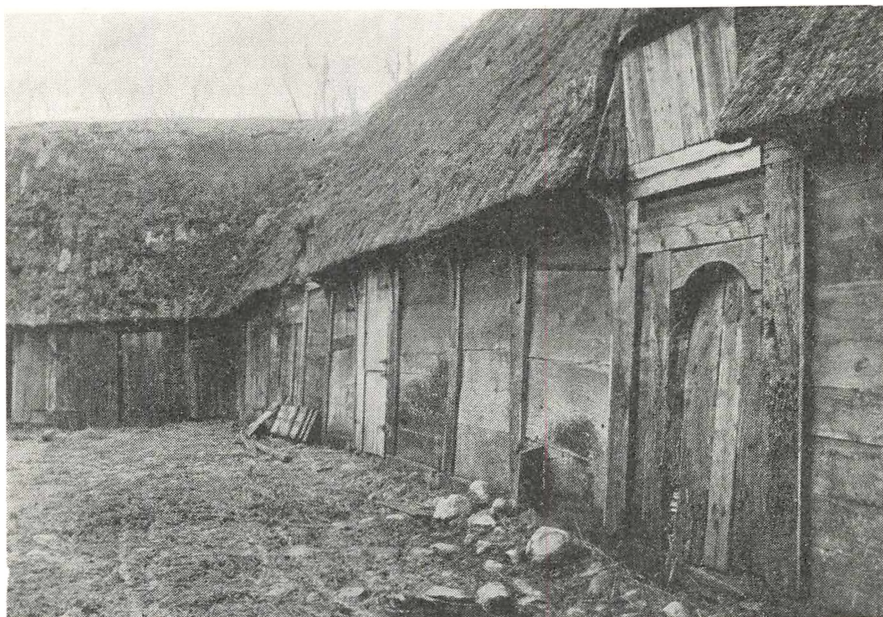
Udlængerne til en bulbygget gård i Ørby ved Haderslev. Vægfelterne mellem de lodrette stolper er lukket med brede planker af eg. Ældre fotografi i Nationalmuseet.
