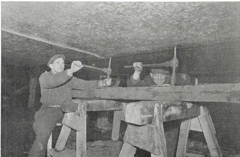
Specialarbejderne Valde og Stoffer viser, hvordan man borede nagler ud.
