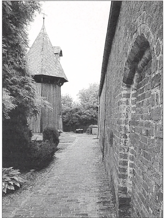
Das vermauerte Nordportal Den tilmurede nordindgang
