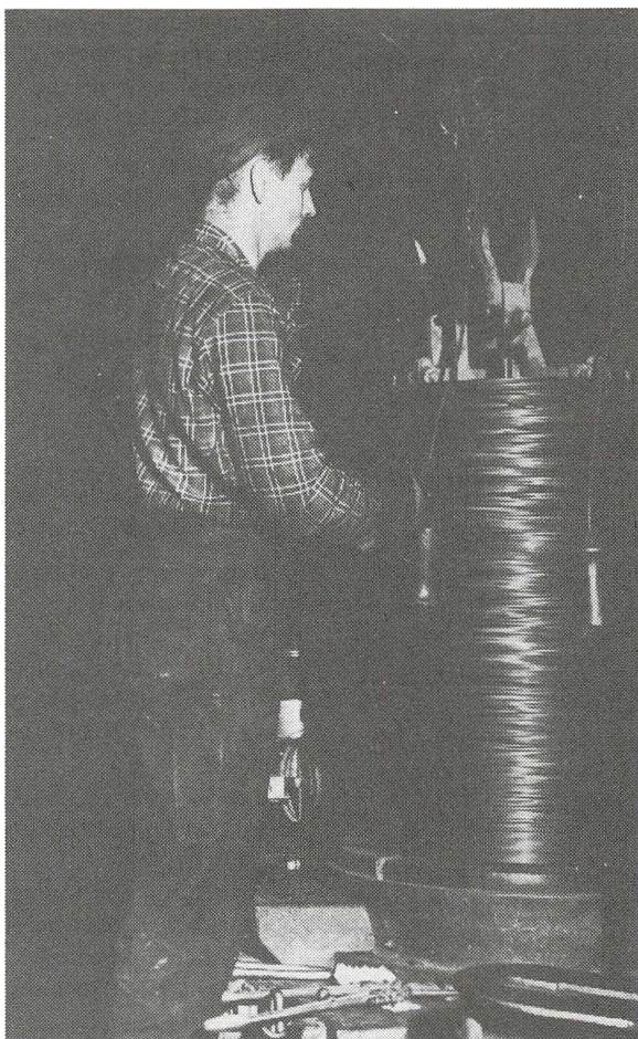
Fra trådtrekkeriet på Spigerverket ca. 1955. Trekkeren plasserer tråden på en buntebenk. Foto: Chra. Spigerverk.
