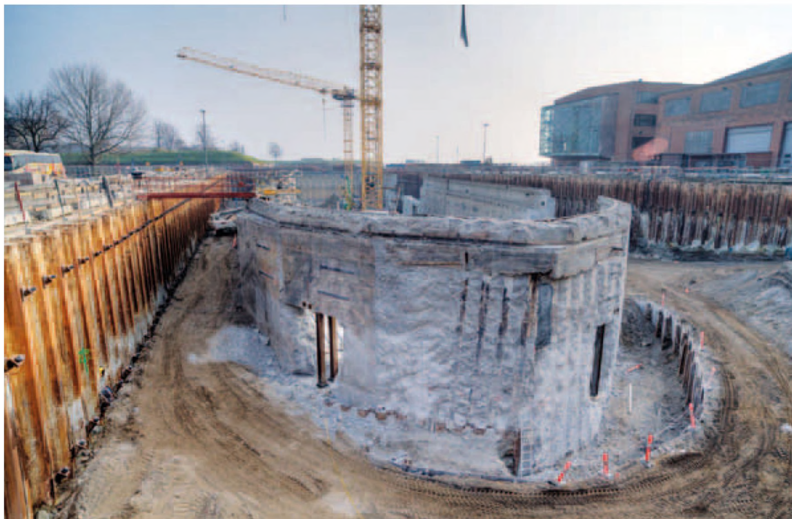
Danmarks nye søfartsmuseum opføres i og omkring dok 1 fra Helsingør Skibsværft. Byggepladsen november 2011. Foto: Ole Thomsen.
