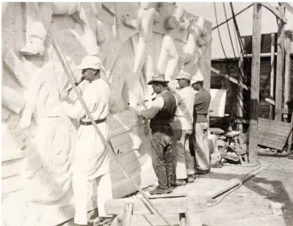
Fig. 10. Svend Rathsack arbejder sammen med tre stenhuggere på det sydøstlige relief. (Ca. 1925-26).
