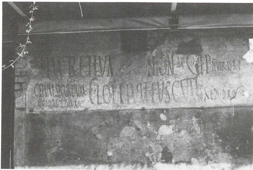
Udsnit af en husfacade tæt besat med valgindskrifter. Muren vender ud mod hovedgaden Via dell'Abbondanza, der blev udgravet efter moderne principper i 1910'erne. Med overdækning og solafskærmning har man forsøgt at bevare det skrøbelige pudslag, som ellers overalt er forsvundet i de dele af byen, der frilagdes i det 18. og 19. århundrede. (Foto: Deutsche archäologische Institut, Rom.)
