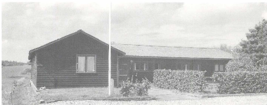
Skydehuset på Ellemosevej, august 2004
