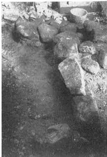
Fundamenter af Kor-Afslutningen.
