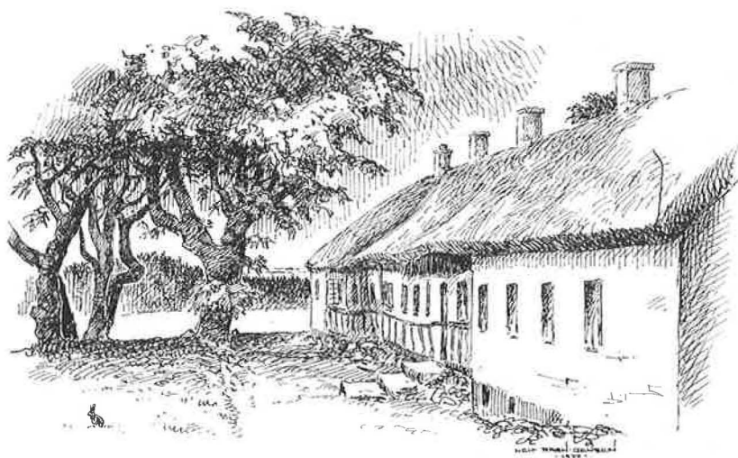
Stuehuset set fra havesiden.
