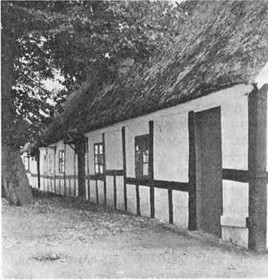
»Østergaards« stuehus, set fra gårdsiden. De gennemgående bjælkehoveder blev savet af for mange år siden, fordi den da- værende ejer »ikke syntes de pyntede«!
