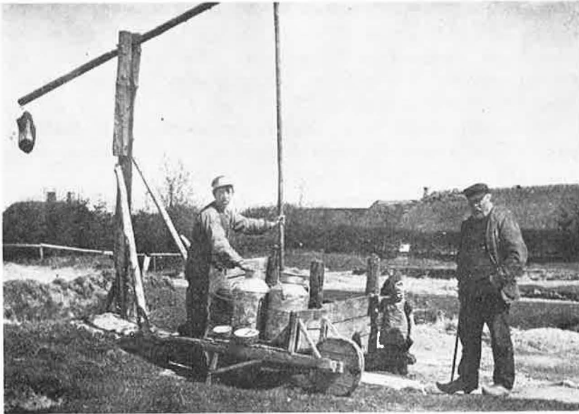
Bykjælen med brøndvippen og lidt af det gamle Revvæld omkring 1912. Manden med stok er Chresten Andersen, »Viborggaarden«, f. 11.-3.-1840, † 6.-3.-1919.
