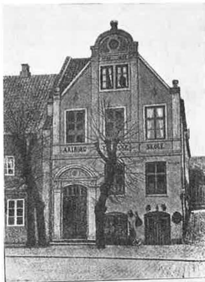
Østerågade nr. 8 som Teknisk Skole 1870–1880.
