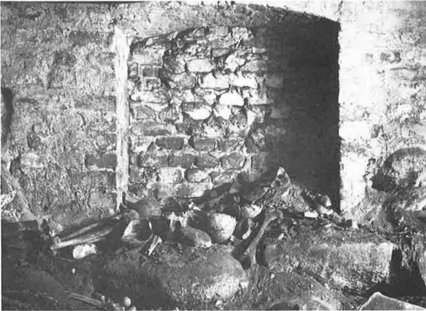
Fra kælderen under det nye kapel.
