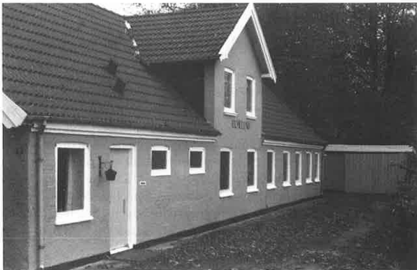
„Elmelunds” stuehus, som det ser ud fra nord 1987.
