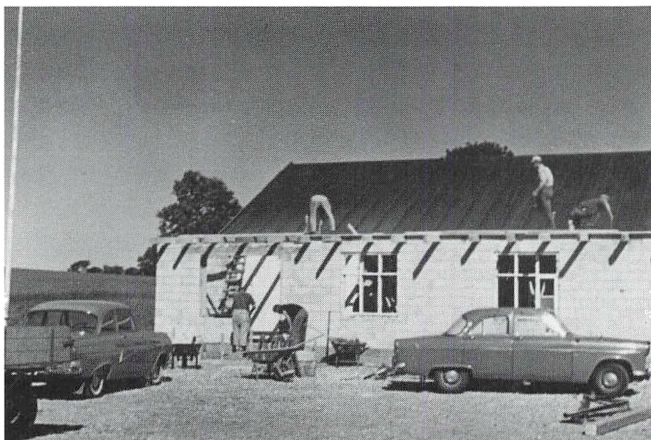
Fra byggeriet af loggiaen i 1965
