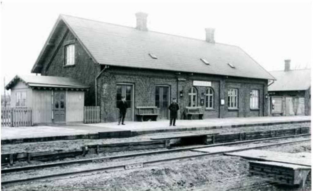
Fiskebæk Station. Til venstre for stationsbygningen ses signalhuset. I forgrunden ses trådtræk, der forbandt håndtagene i signalhuset med signaler og sporskifter. Danmarks Jernbanemuseum. (Billedet er beskåret øverst).
