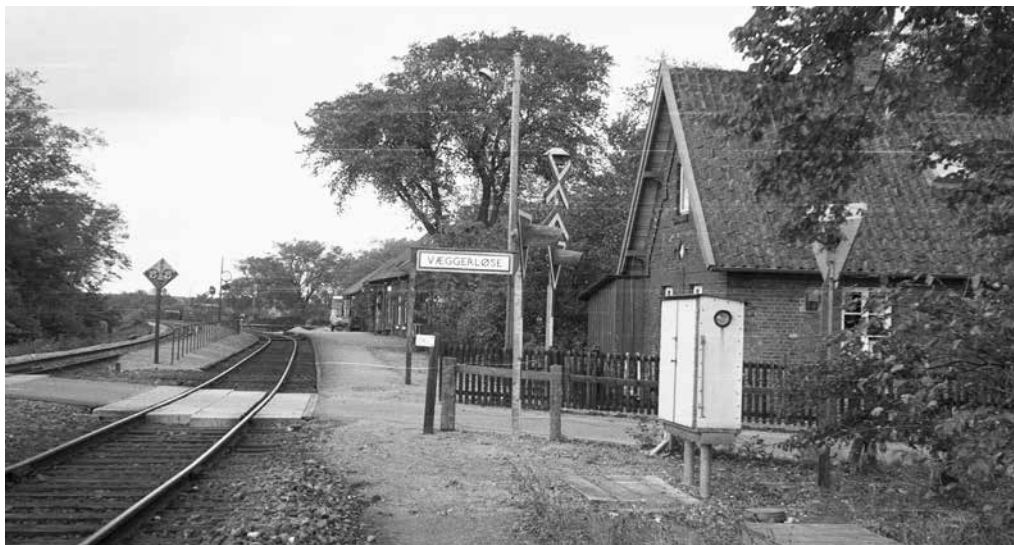
Væggerløse Station efter ændringen. De manuelt betjente bomme er erstattet af et advarselssignalanlæg. Jens Bruun-Petersen. (Billedet er beskåret i top og bund).
