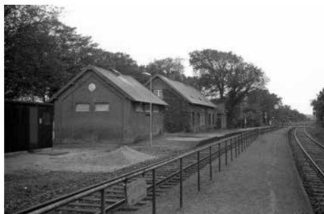
Væggerløse Station efter ændringen. Den sorte træbygning til venstre er relæhytten. Den indeholder sikringsanlæggets relæer. I baggrunden til højre ses de nye signaler. Holger B. D. Sørensen.
