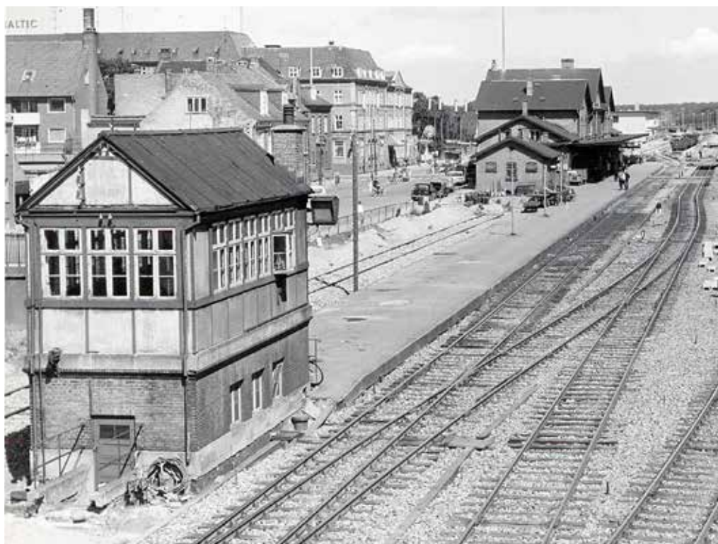
I forgrunden den sydlige post, post 2 i Nykøbing F. Midt i billedet ses den gamle stationsbygning. I baggrunden ses, at anlægsarbejderne med den nye station er i fuld gang. Foto fra 1962. Henning Petersen. (Billedet beskåret i top og bund).
