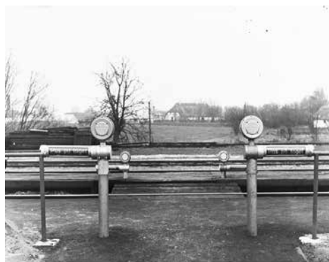
Hvor der var overgang mellem de to perroner på en station, blev der opstillet varslingsanlæg. Danmarks Jernbanemuseum.
