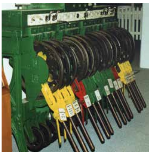
Centralapparat for mekanisk sikringsanlæg af fabrikat Siemens & Halske nyere type. Det var denne type, der var i Væggerløse og Fiskebæk. Ole Edvard Mogensen.
