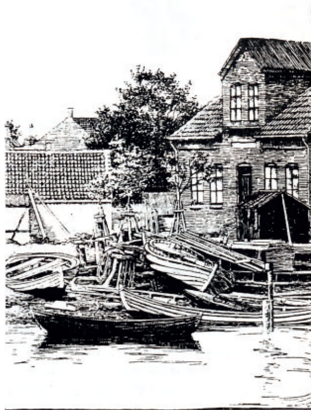
Parti fra havnen ved bygaden i Frederikssund omkring 1880.
