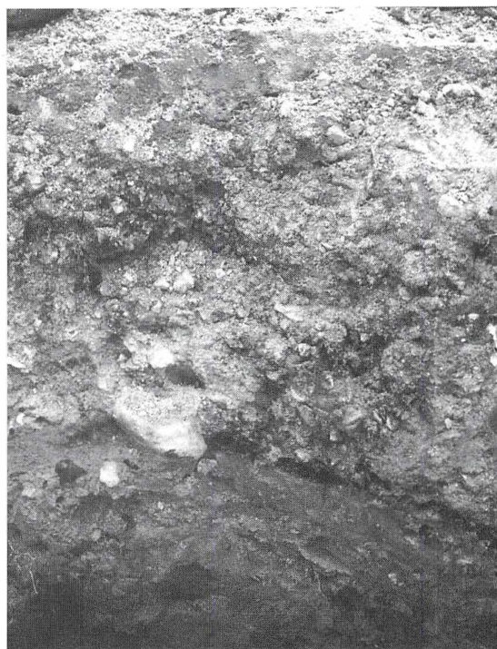
Fig. 9. Nærbillede af vejfundamentet ved Egedalkirken. Vejmaterialer består af sand, grus og sten nedlagt uden nogen synlig plan. Den mørke stribe til højre for stenen er jernudfældninger afsat af nedsivende vand. Nederst i billedet ses undergrundens ler. Billedets bredde svarer til 1 m.
