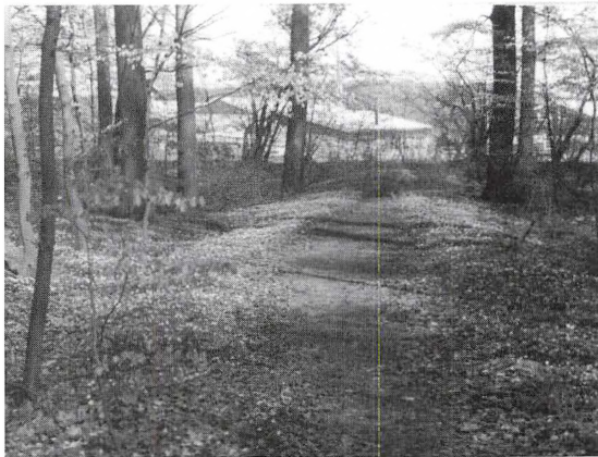
Fig. 12. Den nordligste del af kongevejsstykket i Munkegårde hegn set fra syd. Vejen har her form af en dæmning over det lavtliggende område.
