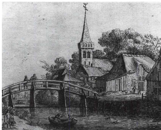
Fig. 4. Vejbro bygget efter samme princip som kongevejsbroerne. De lodrette stolper bærer tværliggende “hamre”, hvorover ligger længdegående “strøer”, der atter bærer den tværgående plankebelægning. Rækværket er støttet af udvendige skrå stivere. Imidlertid var kongevejsbroerne ikke hvælvede på midten som på dette stik af J. V. de Capelle. (Den Kongelige Kobberstiksamling).
