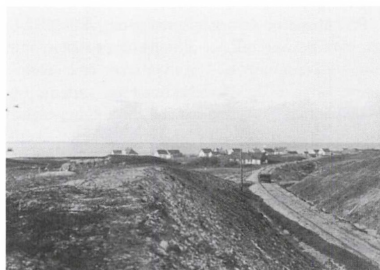
Anlæg af strækningen ned mod Hundested, 1916. (DJK).
