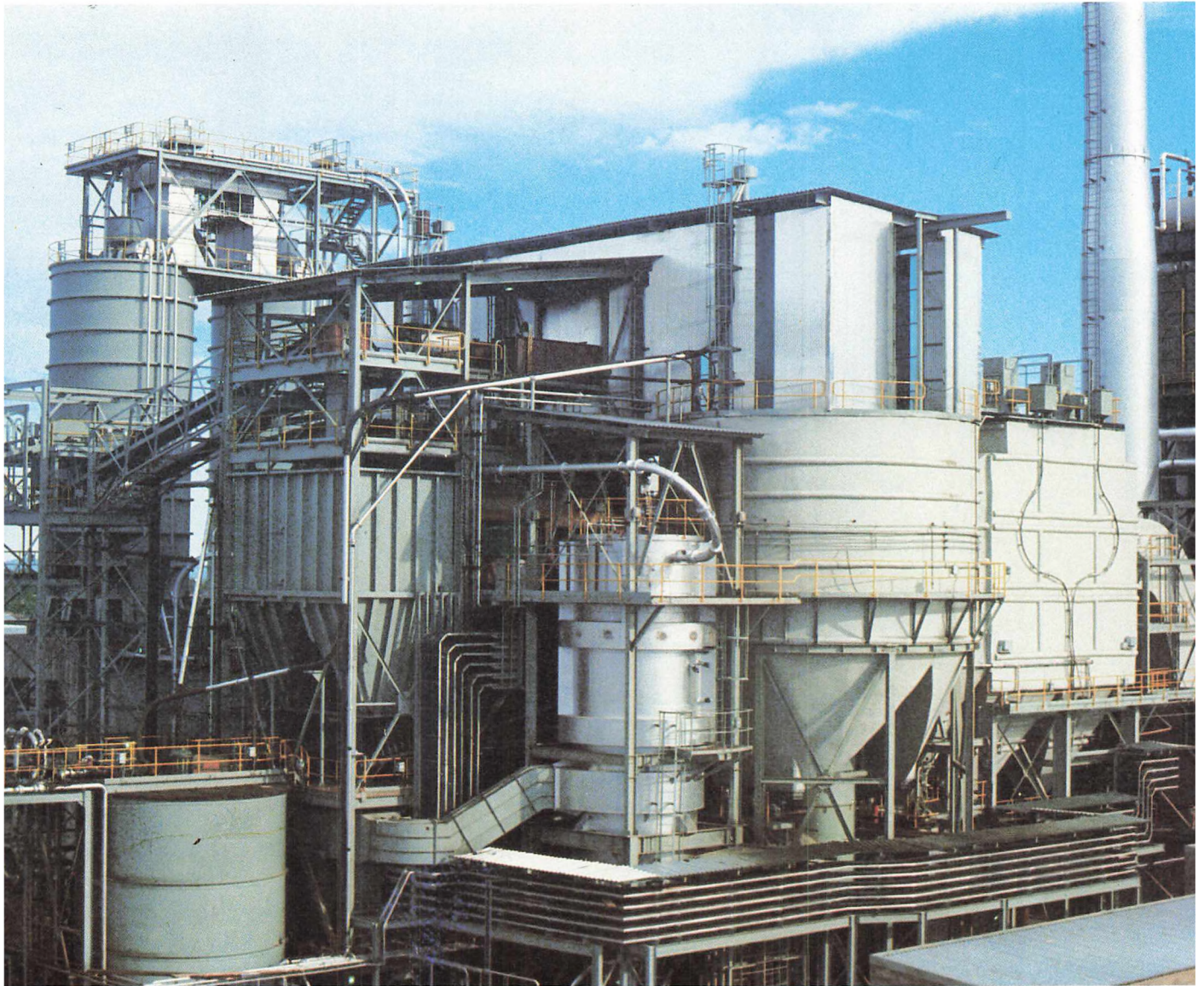
Anlæg til spraytørring af kobber/nikkel-koncentrat, kapacitet 100 tons produkt pr. time.
