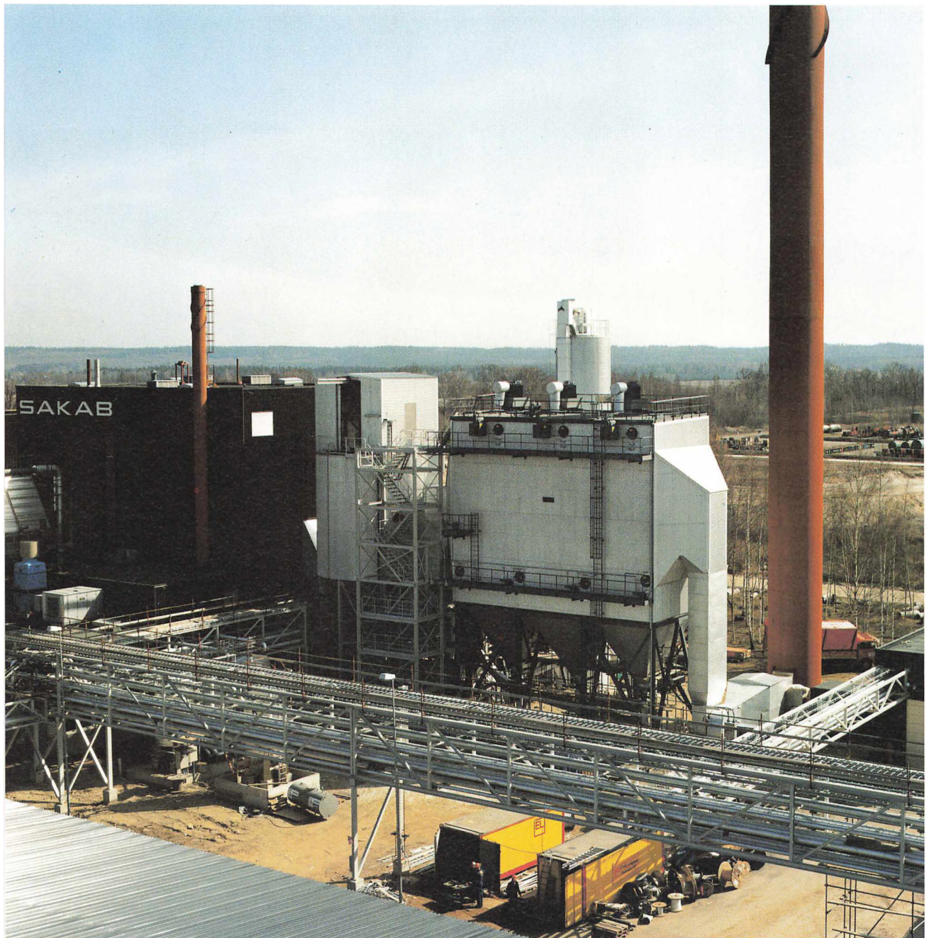
Sprayabsorptionssystem til fjernelse af tungmetaller og andre skadelige stoffer i røggassen fra et industrielt forbrændingsanlæg.
