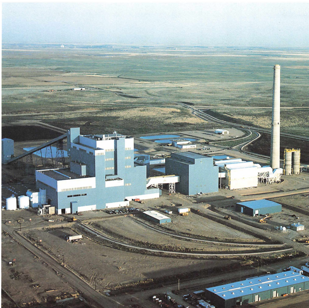
Sprayabsorptionsanlæg til rensning af roggassen fra et kulfyret kraftværk i USA.
