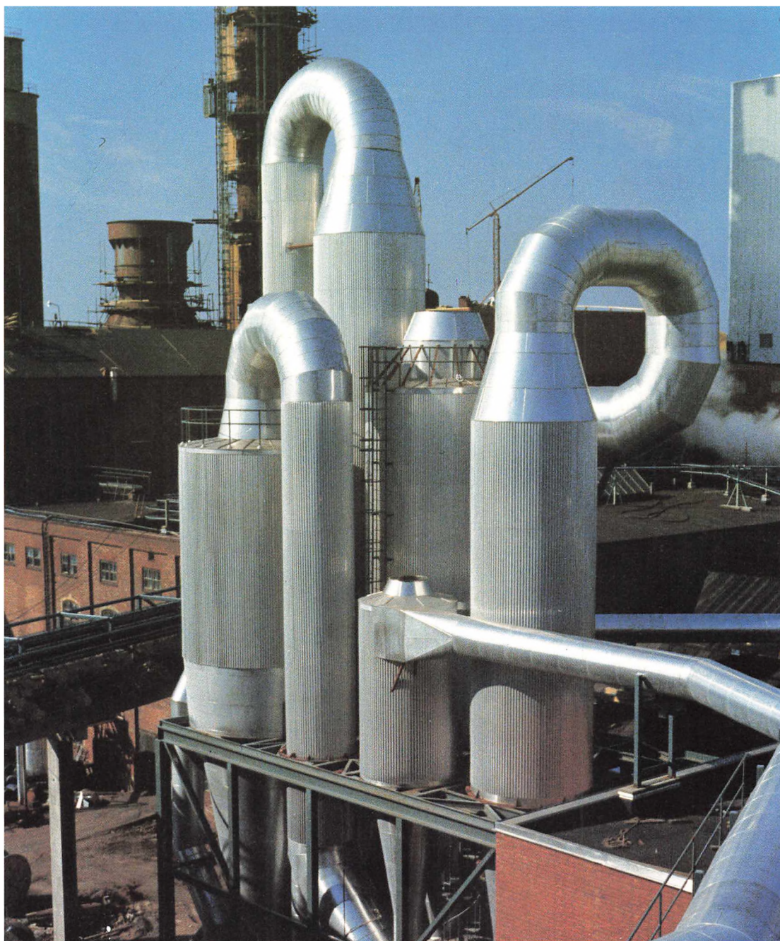
Flashtorringsanlæg til fjernelse af restvand i bleget cellulosemasse, kapacitet 300 tons/dogn.
