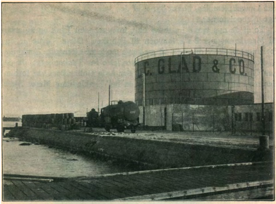
Cisterneanlæg i Københavns Frihavn.
