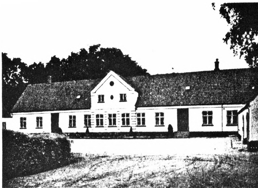
Foto 1960 (ca.): Hovedbygningen på gården "Lergrav" i Aulum sogn, som købtes 1758 af Conrad Christensen Lundsgaard (72) og (88), se side 70, midtpå!
