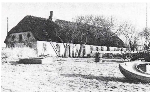
Fig. 2. Skipperhuset i Janderup, set fra syd i 1963. Bag de to vinduer til venstre i facaden og vinduet til højre i gavlen var rummet, hvor potterne blev fundet. Foto: Knud Jensen.
