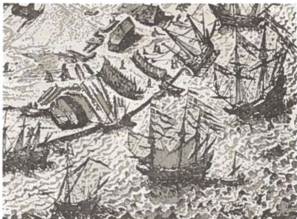
Fig. 63. Skibevarftet paa Bremerholm. Til højre kølhales et Skib. (Efter J. v. Wiercks Stik, Nationalmuseet.)
