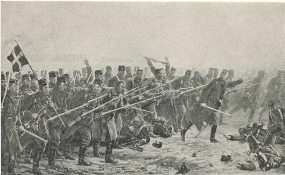
8. Brigades Modangreb under Stormen paa Dybbøl den 18. April 1864.
