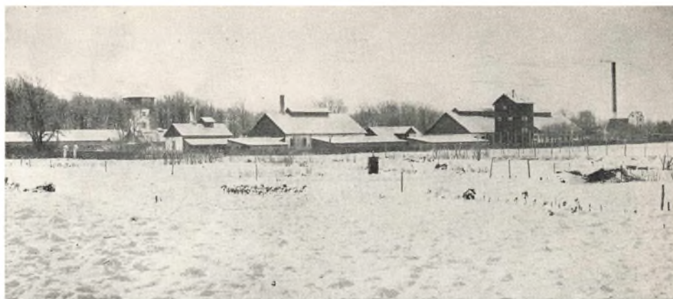
En Del af Krudtværkets Fabrikbygninger.
