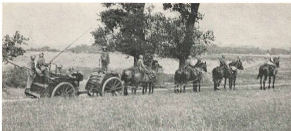
Feltkabelliniebygning, Føring i Vejtræer.
