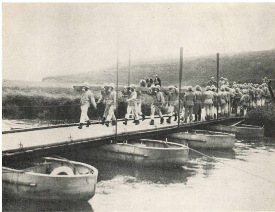
Bygning af Feltbro.
