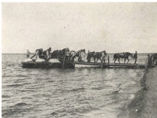
Anlægsbro med Færge.
