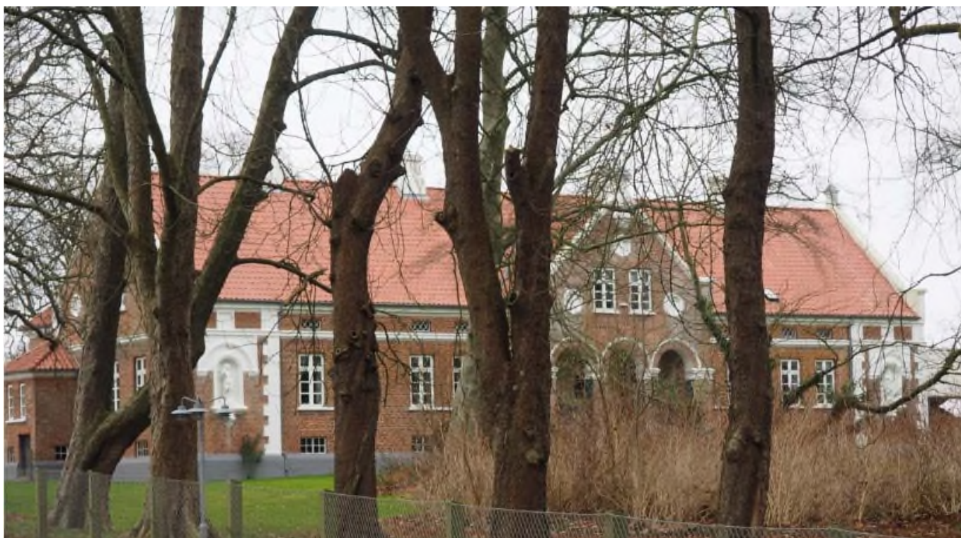
Cathrineberg. Stuehus og staldlænger til gården blev opført af Poul Tonnesen i midten af 1860'erne. Det var på Cathrineberg, at byens første mejeri blev etableret i 1888. Fællesmejeriet blev nedlagt, da man i 1894 indviede det nye andelsmejeri nede i byen. Eget foto, januar 2021.
