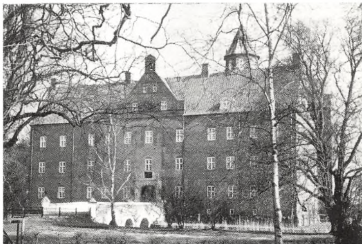
SOSTRUP SLOT. Slottet blev opført i årene 1599-1606 for Jacob Seefeld til Visborggård og dennes enke. Sophie Bile. Det består af tre fløje, alle i tre stokværk. En planlagt fløj blev aldrig opført, og derfor står de to sidefløje med gaule af bindingsværk.
