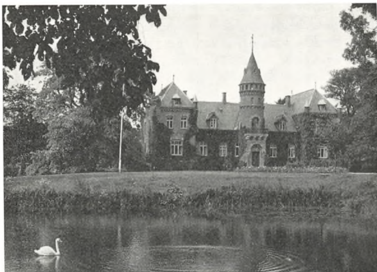
Hovedbygningen set fra indkørselen (fot. Niels Elswing).
