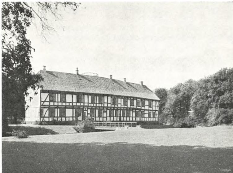
Hovedbygningen set fra haven (fot. Niels Elswing).
