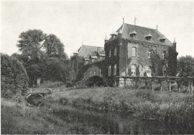
Hovedbygningen set fra haven (fot. Niels Elswing).
