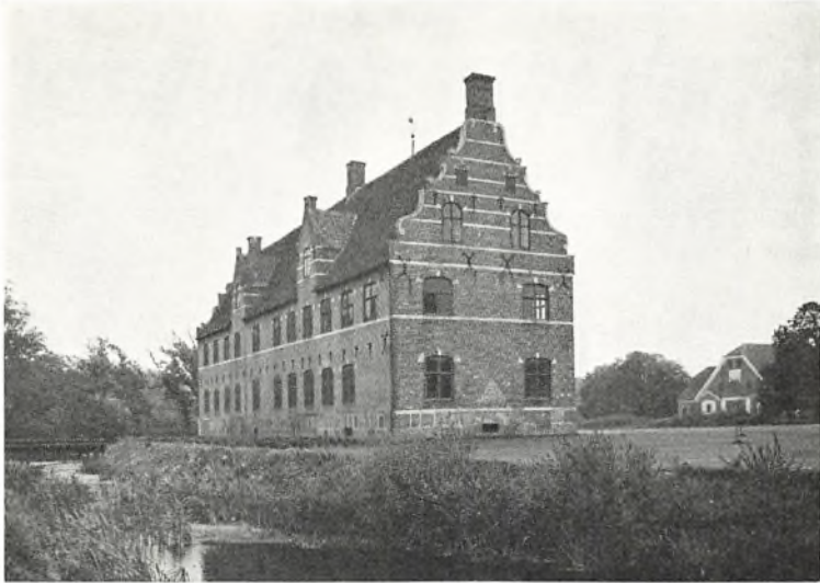
Hovedbygningen set fra nordvest (fot. Niels Elswing).
