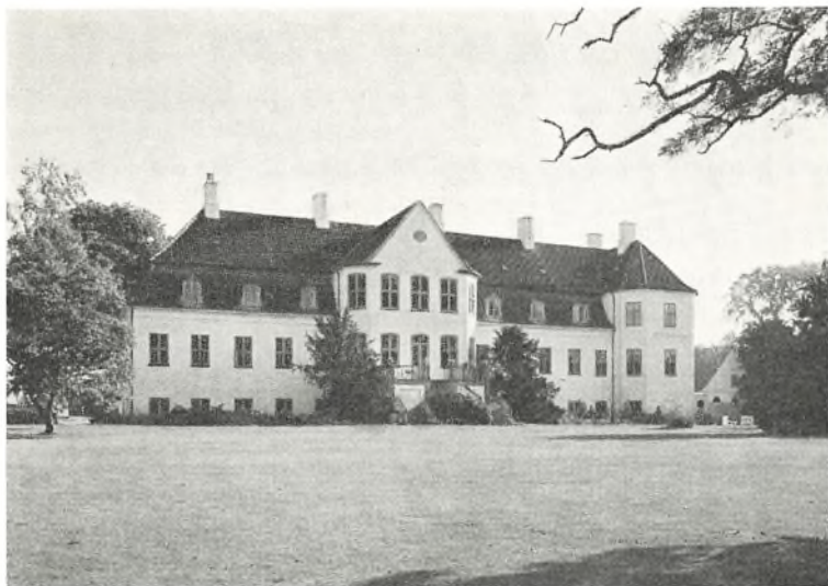
Hovedbygningen set fra haven (fot. Niels Elswing).
