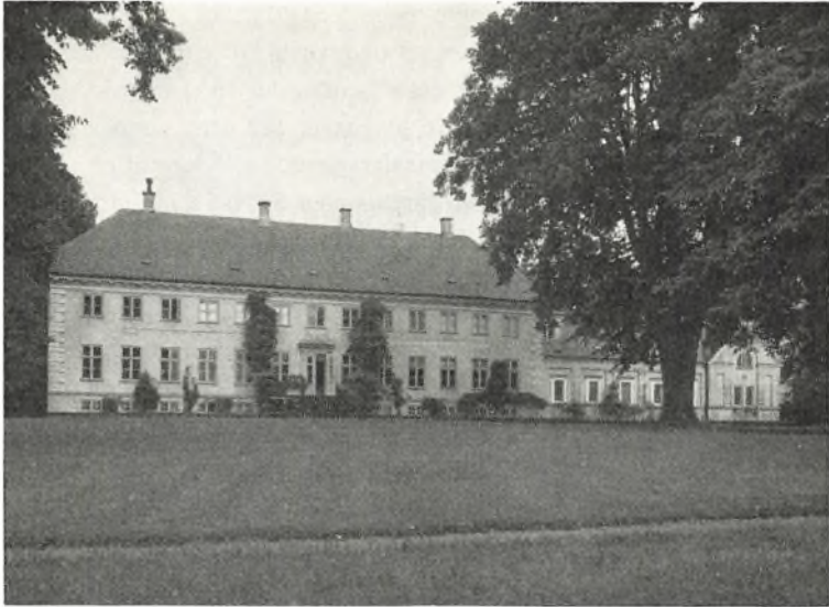
Hovedbygningen set fra haven (fot. Niels Elswing).
