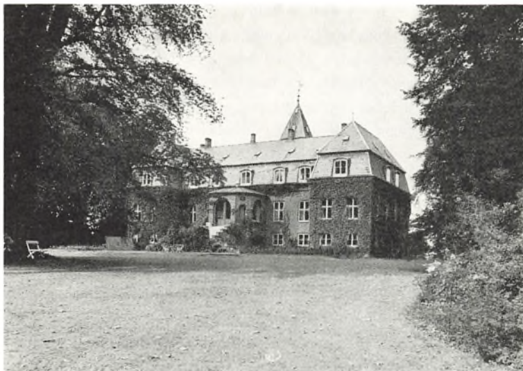
Hovedbygningen set fra haven (fot. Niels Elswing).
