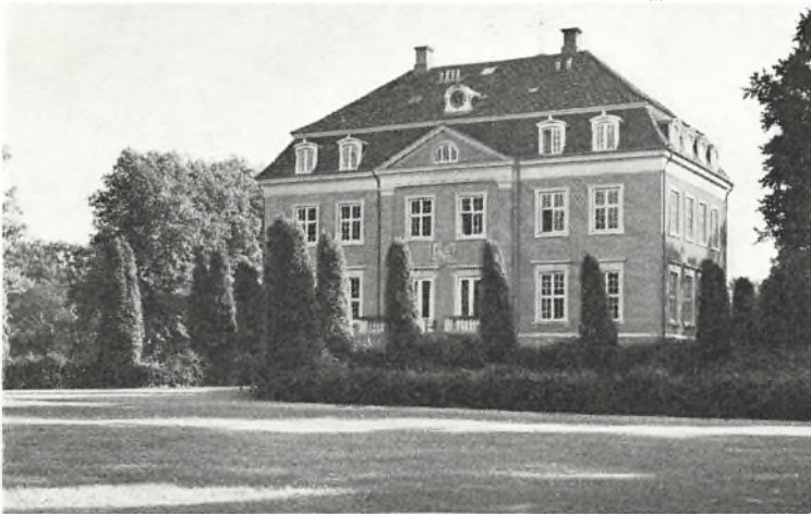
Hovedbygningen set fra nordvest (fot. Niels Elswing).
