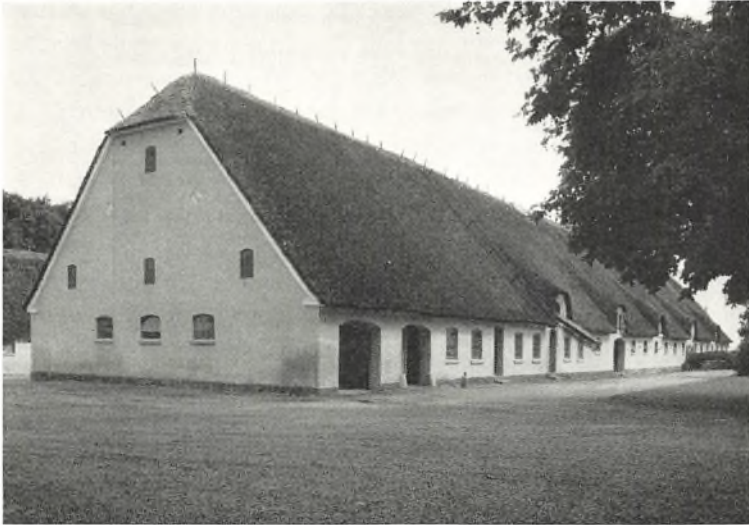
Ladebygningen (fot. Niels Elswing).
