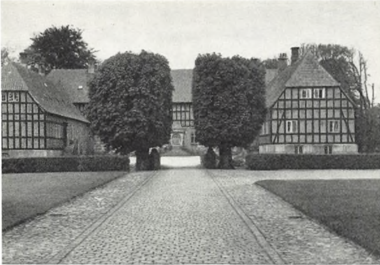
Hovedbygningen set fra øst.
