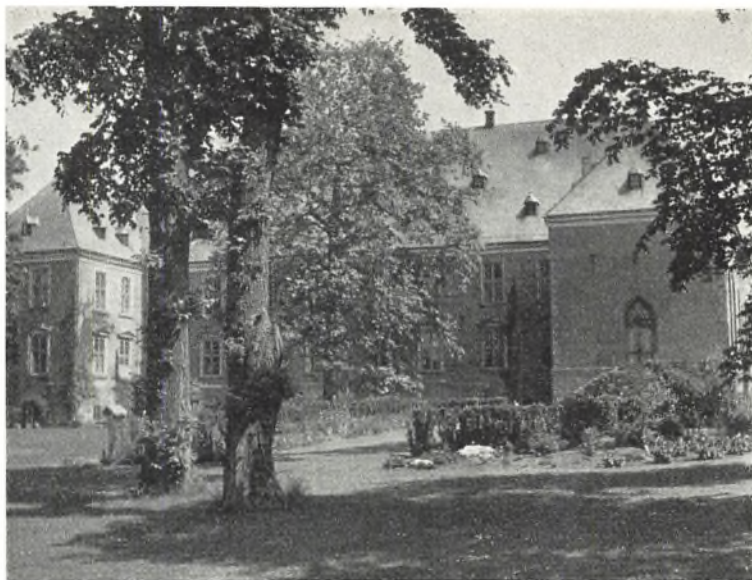
Hovedbygningen set fra parken (fot. Th. Andresen).
